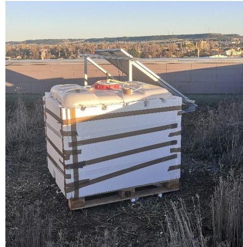
Ilustración 23. Tanque de agua con los paneles de poliestireno
