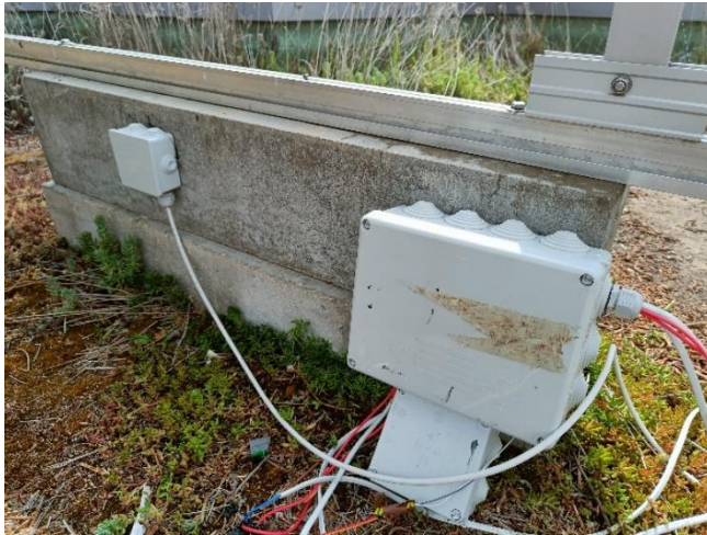
Ilustración 32. Cajas estancas para la electrónica de potencia
