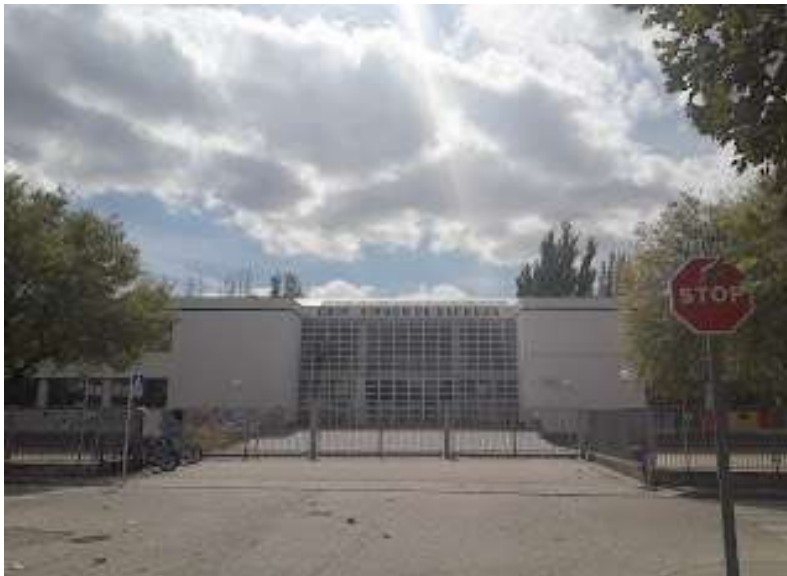
Fachada principal del colegio
