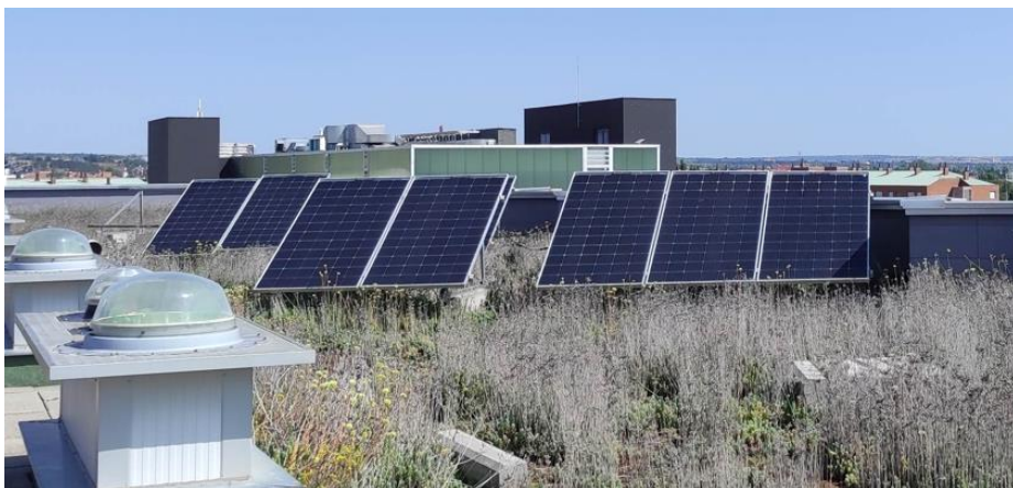
Figura 10: Campo solar monocristalino y bifacial. Fuente: Elaboración propia.
