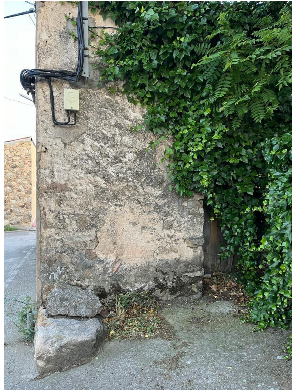
Figura 3.5. Ejemplo de casa construida sobre la roca madre. Fuente: elaboración propia.
