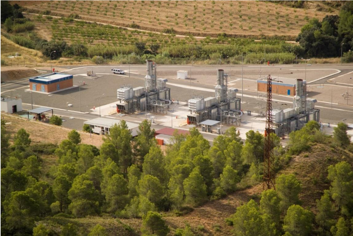
Figura 3. Equipos de turbocompresores en la EC de Tivissa (Tarragona). Fuente: Enagás S.A
