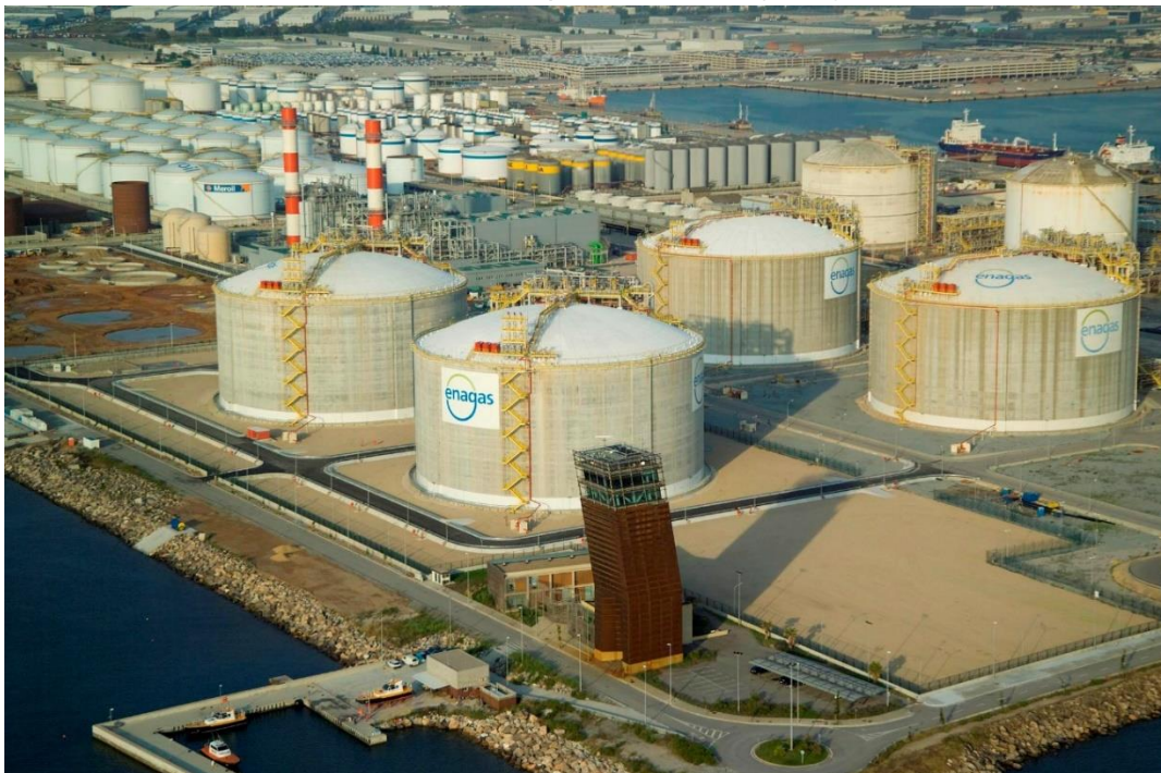
Figura 2. Planta de regasificación de Barcelona. Fuente: Enagás S.A.
