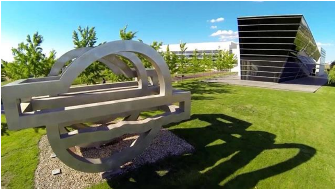
Figura 14. Instalaciones de Repsol Technology Lab en Móstoles. Fuente: Repsol
