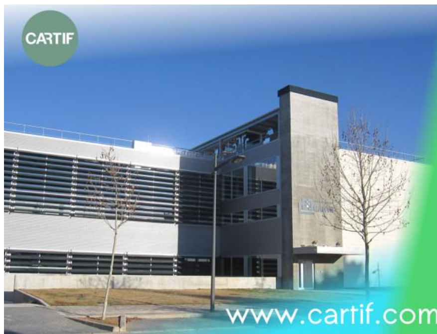
Ilustración 1: Edificio CARTIF 3. Extraída de https://www.Cartif.es
