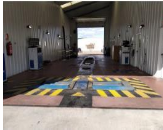
Imagen 5. Ventilación natural de la nave (Elaboración Propia)
