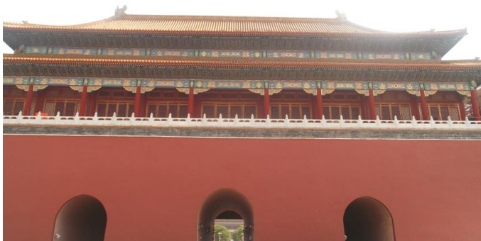
Fig. 20. Muro rojo de la Ciudad Prohibida
