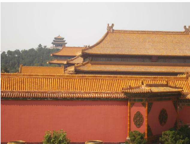
Fig. 26. Tejados dorados de la Ciudad Prohibida en Pekín
