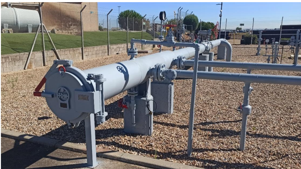
Figura 26: Trampa rascador típica
