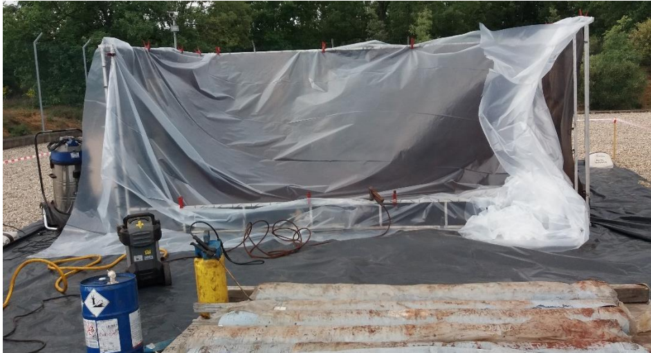
Figura 33: Lugar de trabajo preparado para la limpieza del pig
