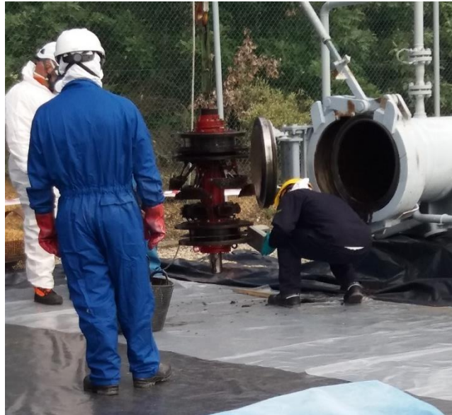
Figura 31: Suelo forrado para proteger el suelo de posibles derrames de material
