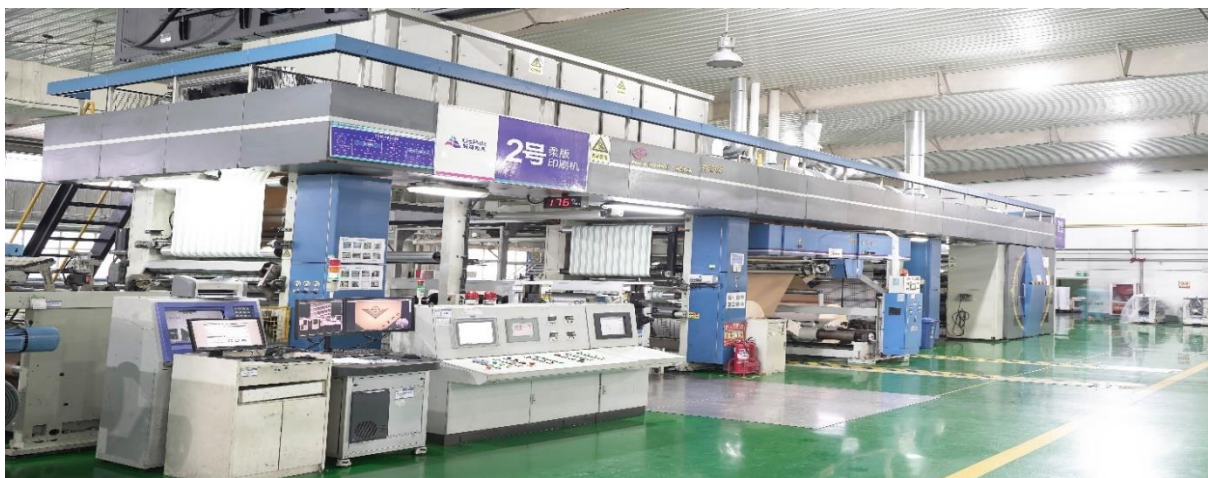
Figura 7. Instalación de impresión
