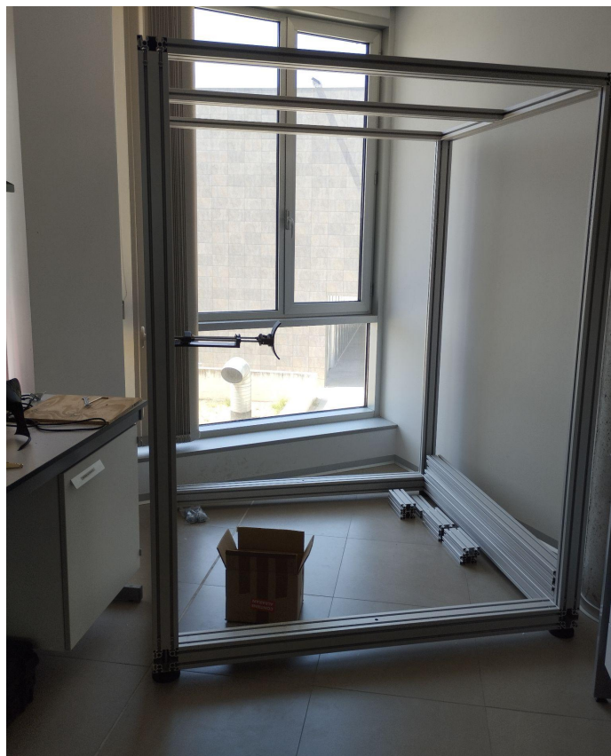
Fig. 63 Estructura principal montada
