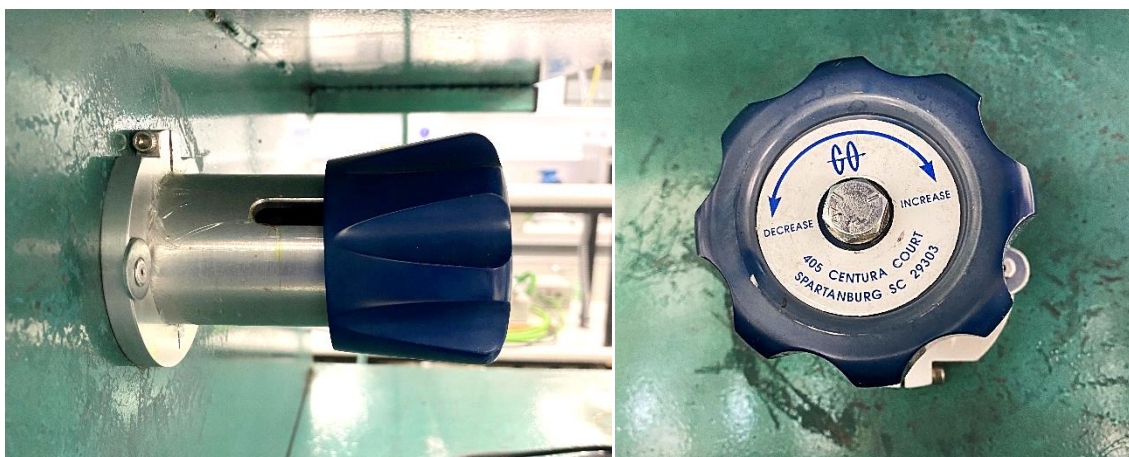
Figura 14: Válvula de descompresión de la planta SAS
