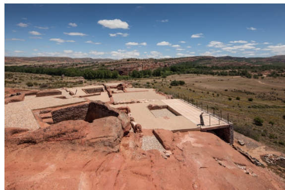
Fig. 8 Vista general de la Casa del acueducto [LABPAP]
