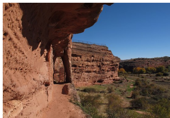
Fig. 12 Paso del acueducto [44]
