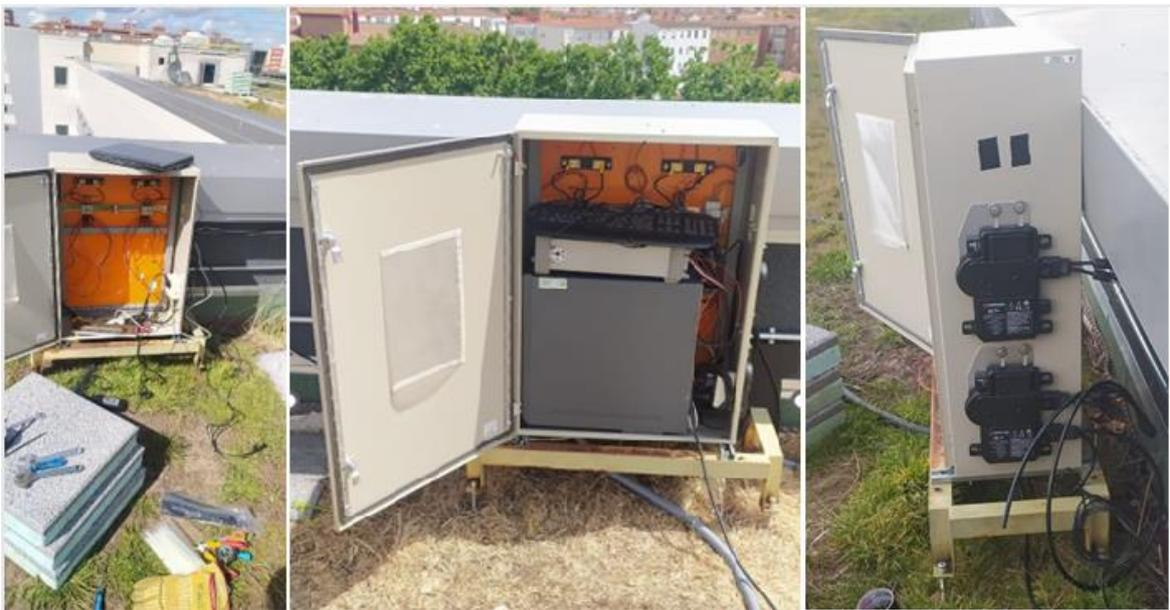
Figura 5.8 1 – A la izquierda emplazamiento y cableado del armario, a la derecha detalle de los inversores, y en el centro estado final del armario con todos los componentes ya en su interior *(Elaboración propia)*
