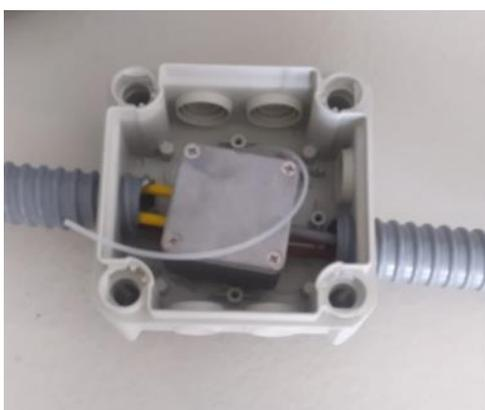
Figura 5.10 1 – Detalle de la caja metálica empleada para la soldadura ya instalada dentro de la caja estanca (Elaboración propia)
