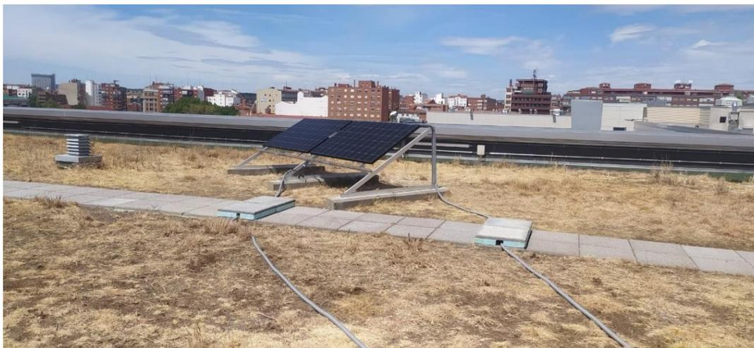
Figura 5.9 1 – Conducción del cableado hasta el armario. A la izquierda el circuito de potencia y a la derecha el circuito de señal (Elaboración propia)
