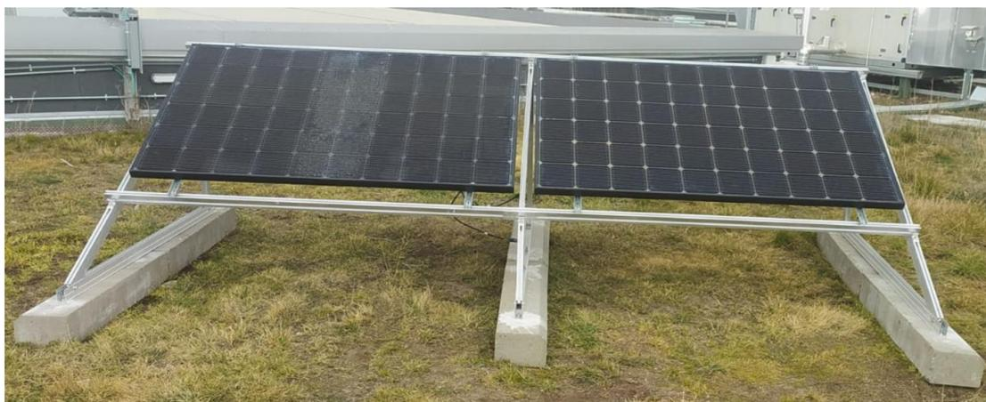
Figura 5.5 1 - Instalación de los paneles fotovoltaicos sobre la estructura soporte *(Elaboración propia)*
