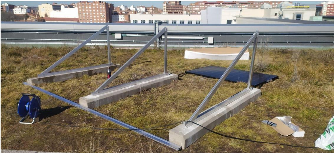
Figura 5.4 1 - Lastres de hormigón con orientación sur y proceso de montaje de la estructura anclada sobre ellos *(Elaboración propia)*
