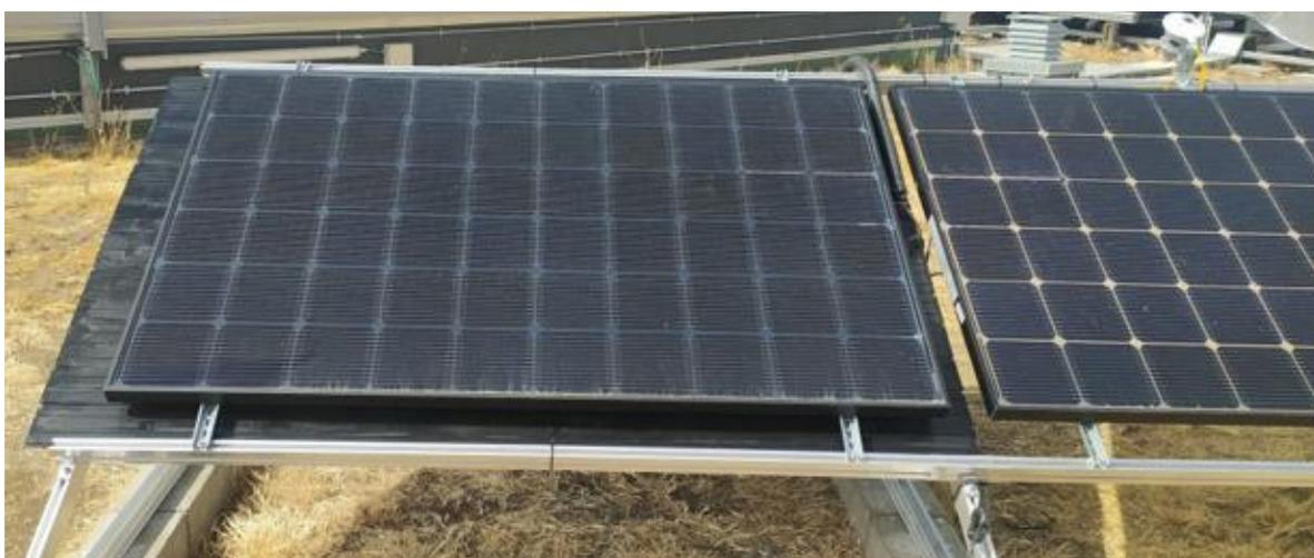
Figura 5.17 1 - Vista por delante del panel solar ya sombreado con la estructura de madera (*Elaboración propia*)
