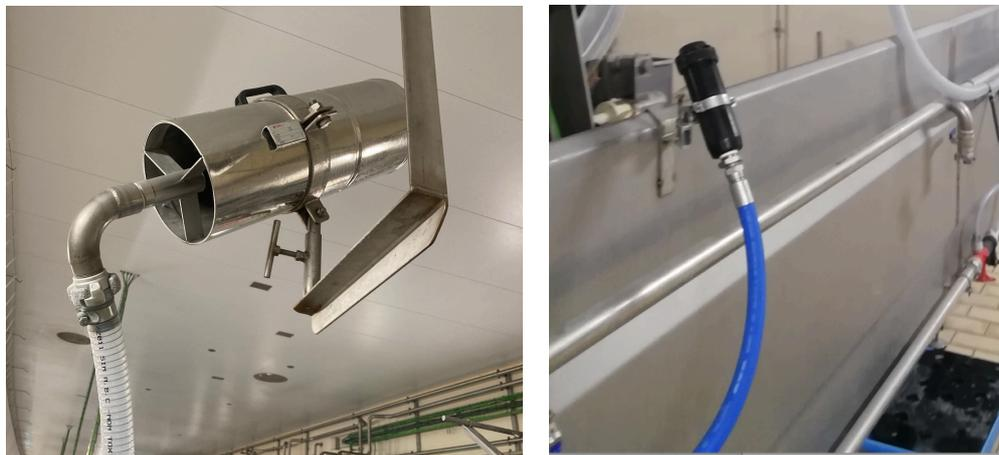
Figura 30. Ejemplo de suministrador de espuma y aspersor de aclarado. Fuente: Fotografías tomadas en campo durante el montaje
