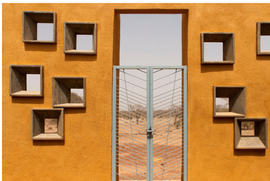
Fig. 39. Perforaciones en muro perimetral.
