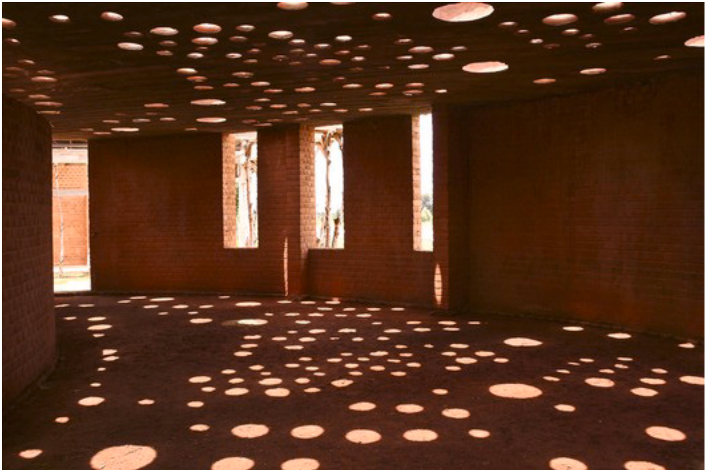
Fig. 65. Perforaciones en la cubierta
