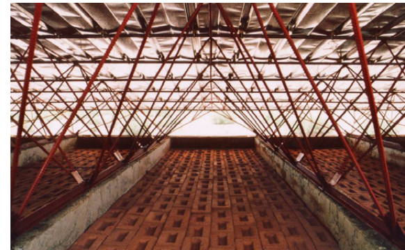
Fig. 26. Detalle de la cubierta
