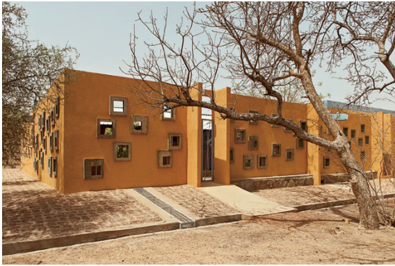
Fig. 43. Exterior de los muros
