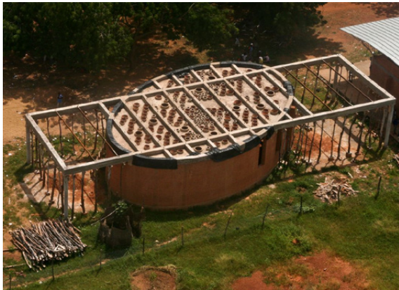
Fig. 67. Vista aérea en construcción
