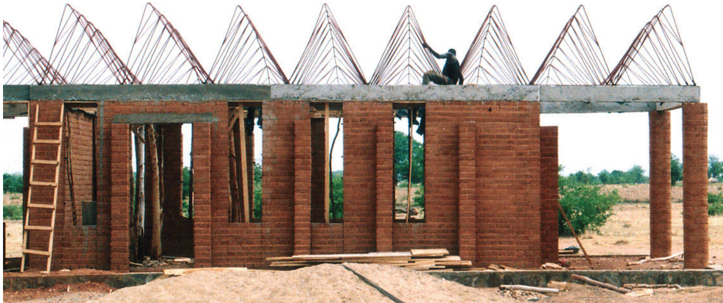
Fig. 23. Colocación de la cercha metálica
