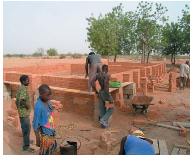
Fig. 21. Proceso de construcción
