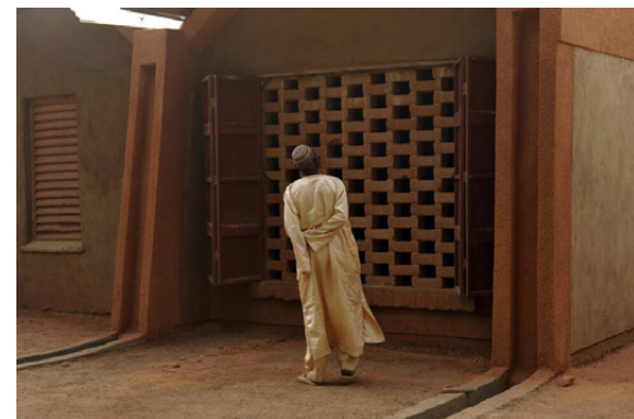
Fig. 83. Detalle de las perforaciones en fachada
