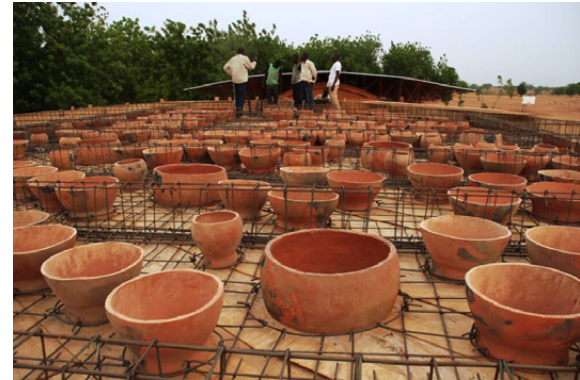
Fig. 63. Cubierta de vasijas
