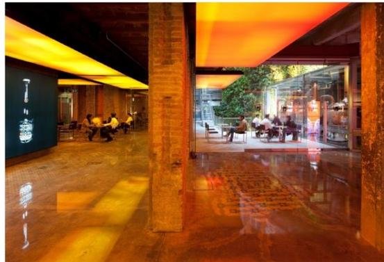
Imagen 23: solados interiores del edificio, se preservan sus mosaicos originales protegidos por resina.
