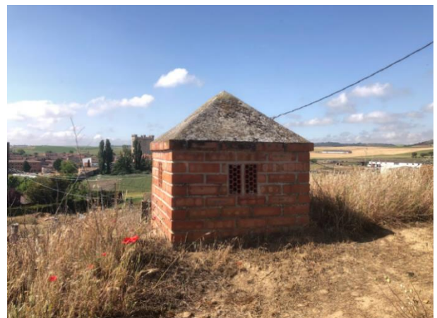
Fig. 4.25 Zarcera de nueva ejecución en ladrillo caravista - Elaboración propia
