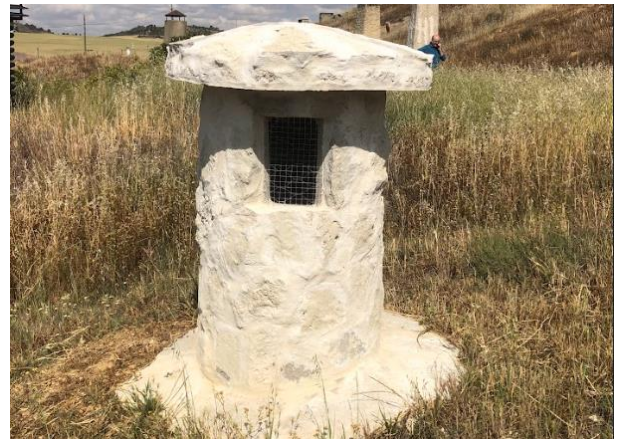
Fig. 4.23 Zarcera de nueva ejecución en piedra - Elaboración propia
