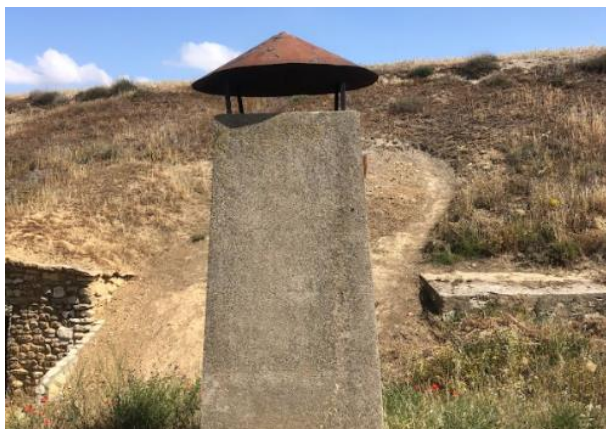
Fig. 4.26 Zarcera de nueva ejecución en hormigón - Elaboración propia
