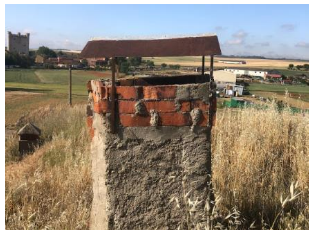
Fig. 4.16 Zarcera reformada con ladrillo y metal - Elaboración propia.
