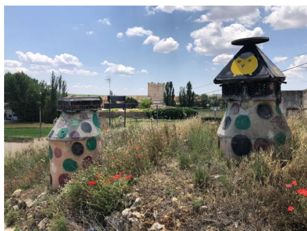
Fig. 4.31 Zarcera de nueva ejecución en hormigón - Elaboración propia
