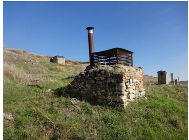
Fig. 4.8 Zarcera reformada con metal - Elaboración propia.
