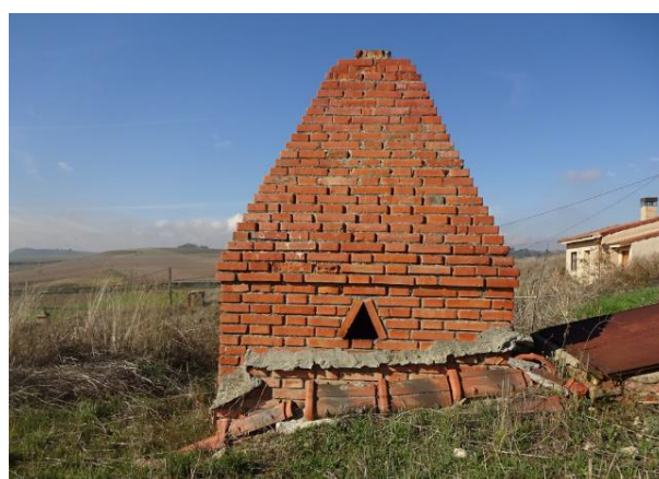
Fig. 4.29 Zarcera de nueva ejecución en ladrillo caravista - Elaboración propia
