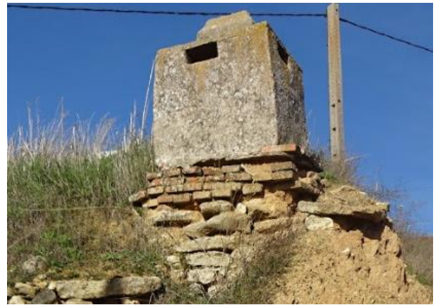
Fig. 4.12 Zarcera reformada con hormigón - Elaboración propia.
