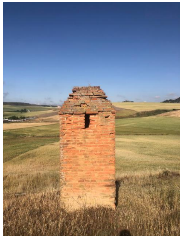
Fig. 4.5 Zarcera original de ladrillo - Elaboración propia
