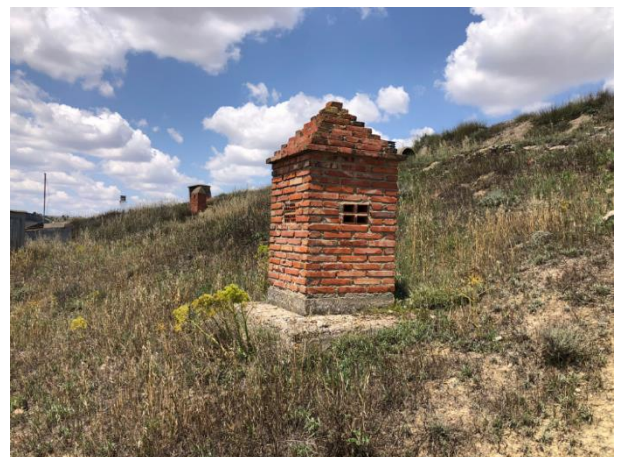
Fig. 4.14 Zarcera reformada con ladrillo - Elaboración propia.
