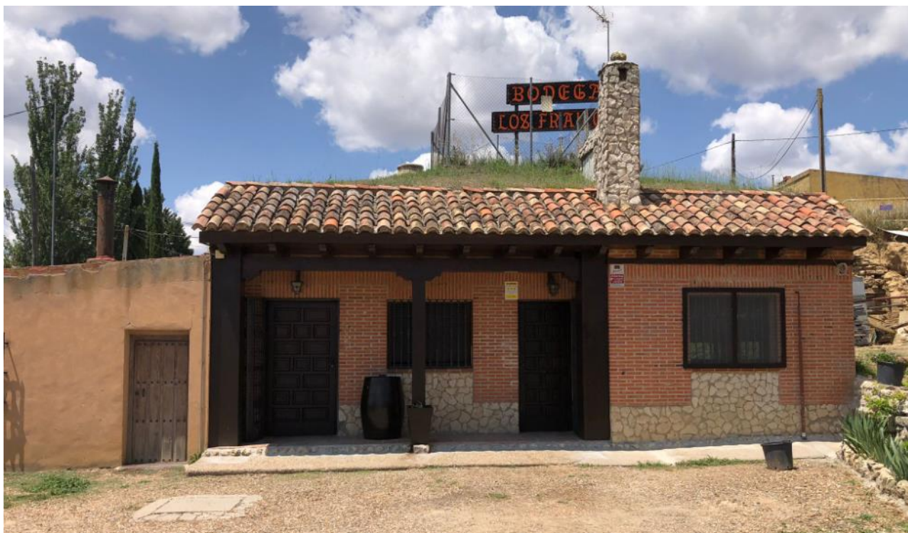
Fig. 4.57 Frente de fachada de nueva ejecución – Elaboración propia.
