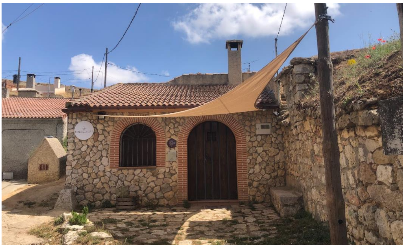
Fig. 4.58 Frente de fachada de nueva ejecución – Elaboración propia.
