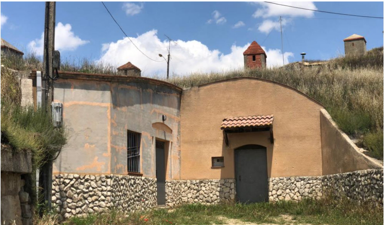
Fig. 4.56 Frente de fachada de nueva ejecución – Elaboración propia
