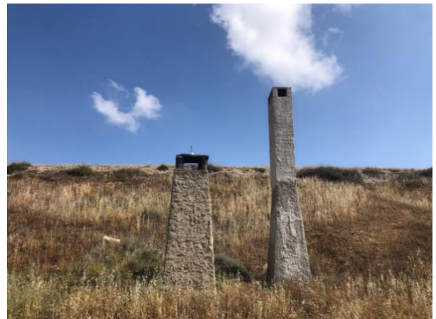
Fig. 4.24 Zarcera de nueva ejecución en ladrillo revestido - Elaboración propia
