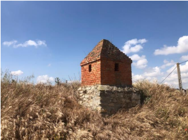
Fig. 4.3 Zarcera original de ladrillo - Elaboración propia
