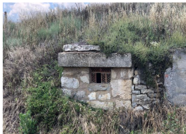
Fig. 4.28 Zarcera de nueva ejecución en piedra, hormigón y ladrillo - Elaboración propia
