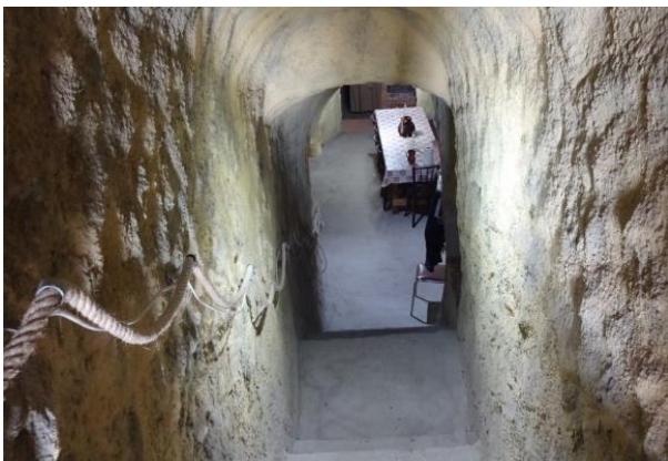
Fig. 3.9 Cañón de acceso con bóveda excavada – Jové Sandoval, F., Bodegas históricas de Fuensaldaña; tradición y futuro vitivinícola , 2023
