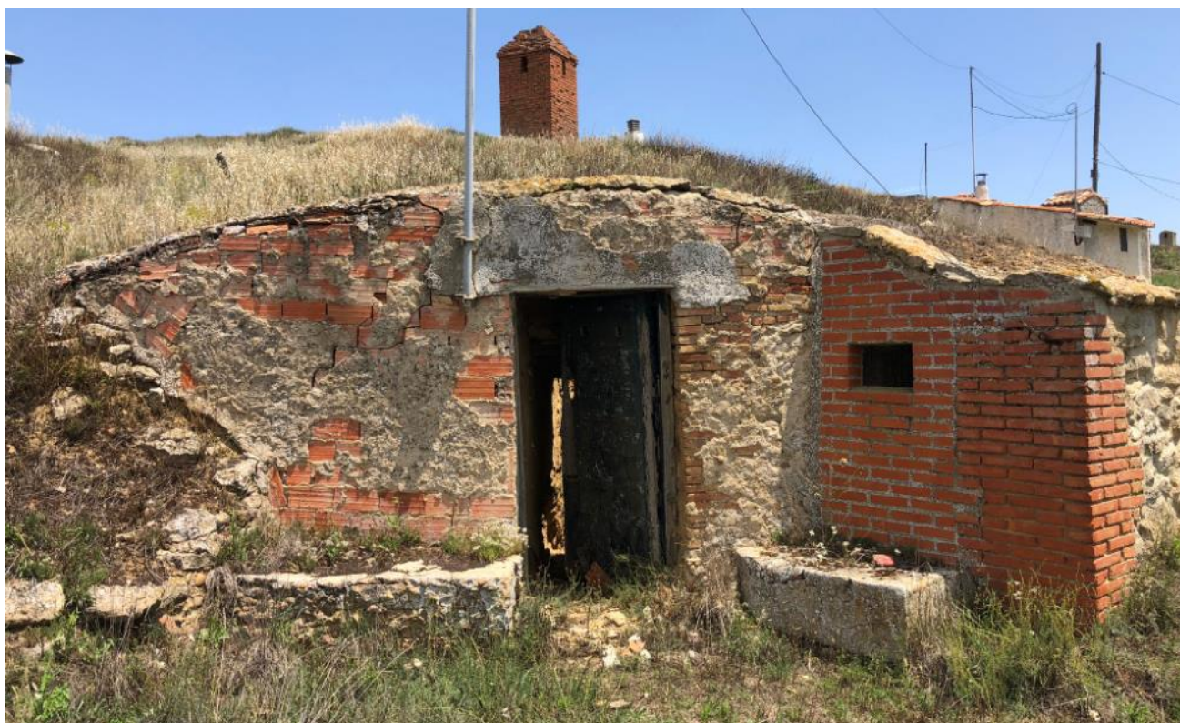
Fig. 4.52 Frente de fachada reformado con ladrilo – Elaboración propia.
