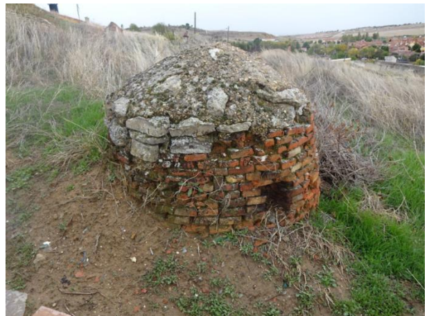
Fig. 4.9 Zarcera reformada con piedra - Elaboración propia.
