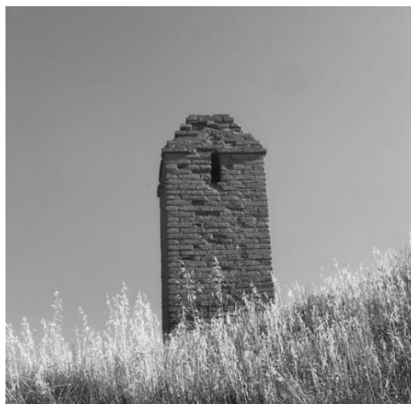
Fig. 4.1 Zarcera original de ladrillo – Elaboración propia.
