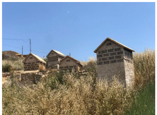
Fig. 4.10 Zarcera reformada con ladrillo - Elaboración propia.
