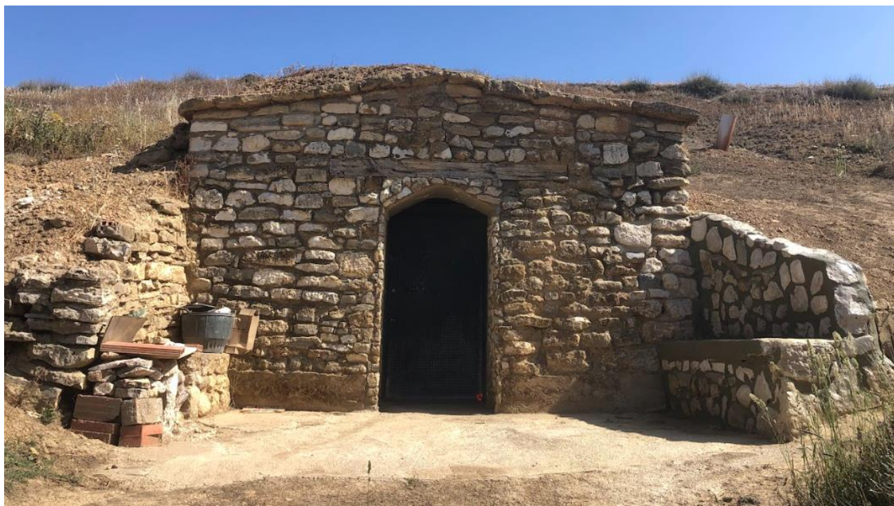
Fig. 4.51 Frente de fachada reformado con piedra – Elaboración propia.
