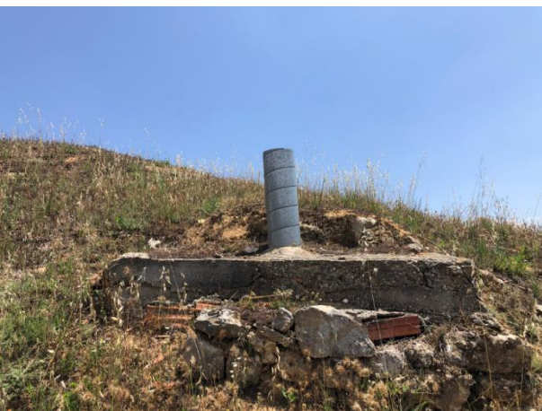
Fig. 4.15 Zarcera reformada con metal y hormigón - Elaboración propia.
