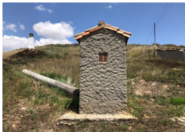
Fig. 4.27 Zarcera de nueva ejecución en ladrillo revestido - Elaboración propia
