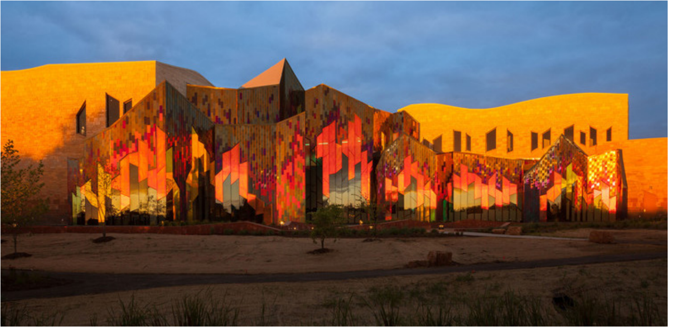
Fig.85. Quema del campo en la construcción
