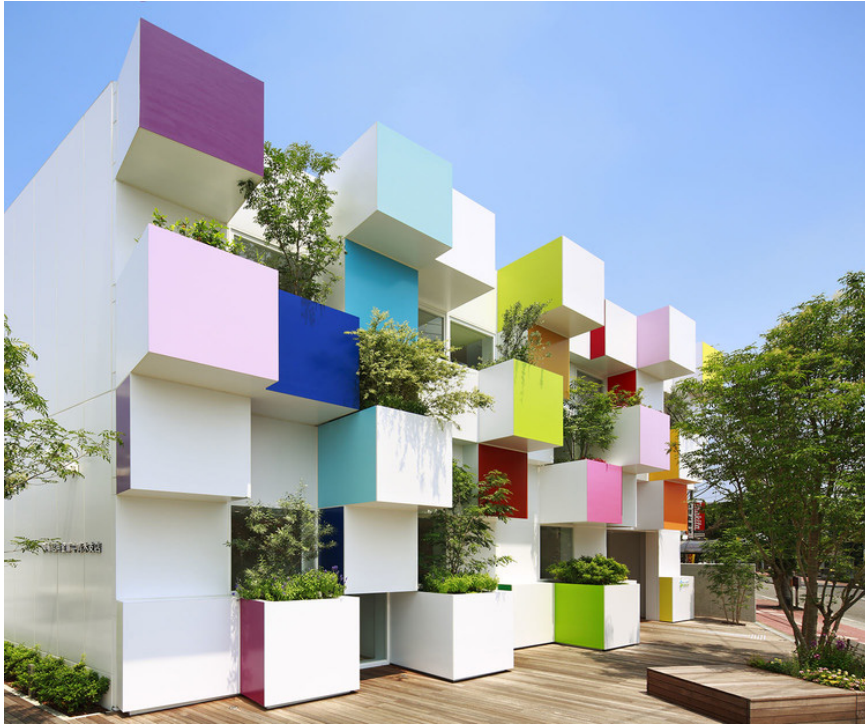
Fig.57. Fachada principal del proyecto
