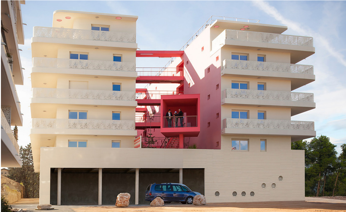
Fig.124. Grieta de color en el interior
