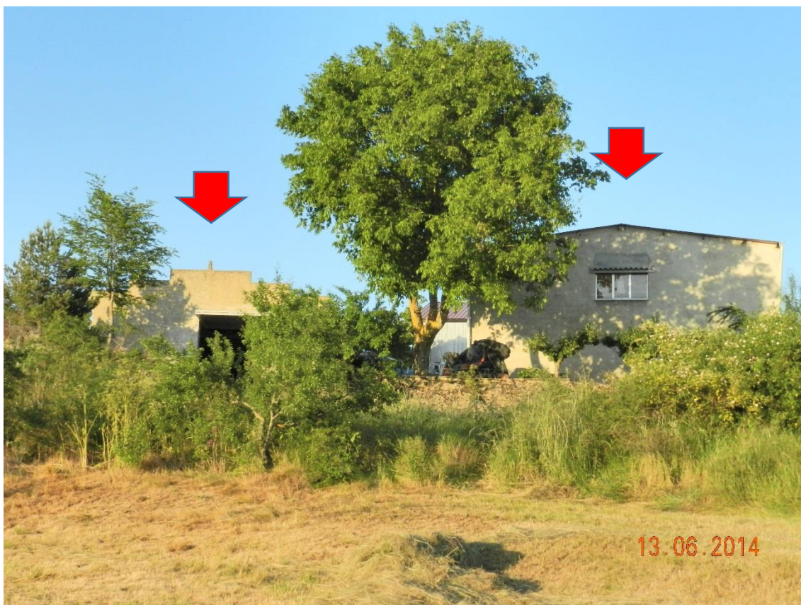
Ilustración 3. NAVES DE LA INDUSTRIA CERVECERA -NAVE 1 (DERECHA) Y NAVE 2 (IZQUIERDA)-
