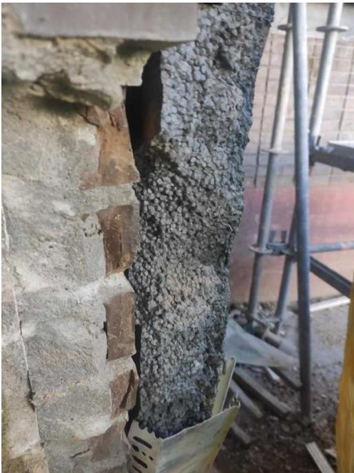
Figura 87. El hormigón existente y el sistema de aislamiento (Foto del Autor)
