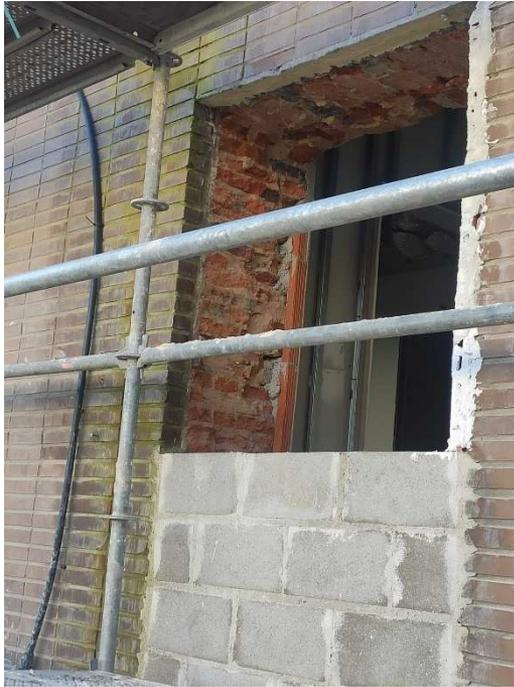
Figura 85. Fachada con ladrillos originales e intervención con bloques de hormigón (Foto del Autor)
