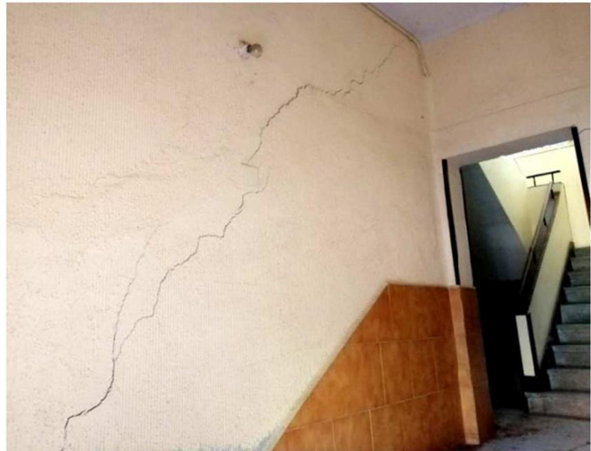
Figura 81. Fisuras en el interior
