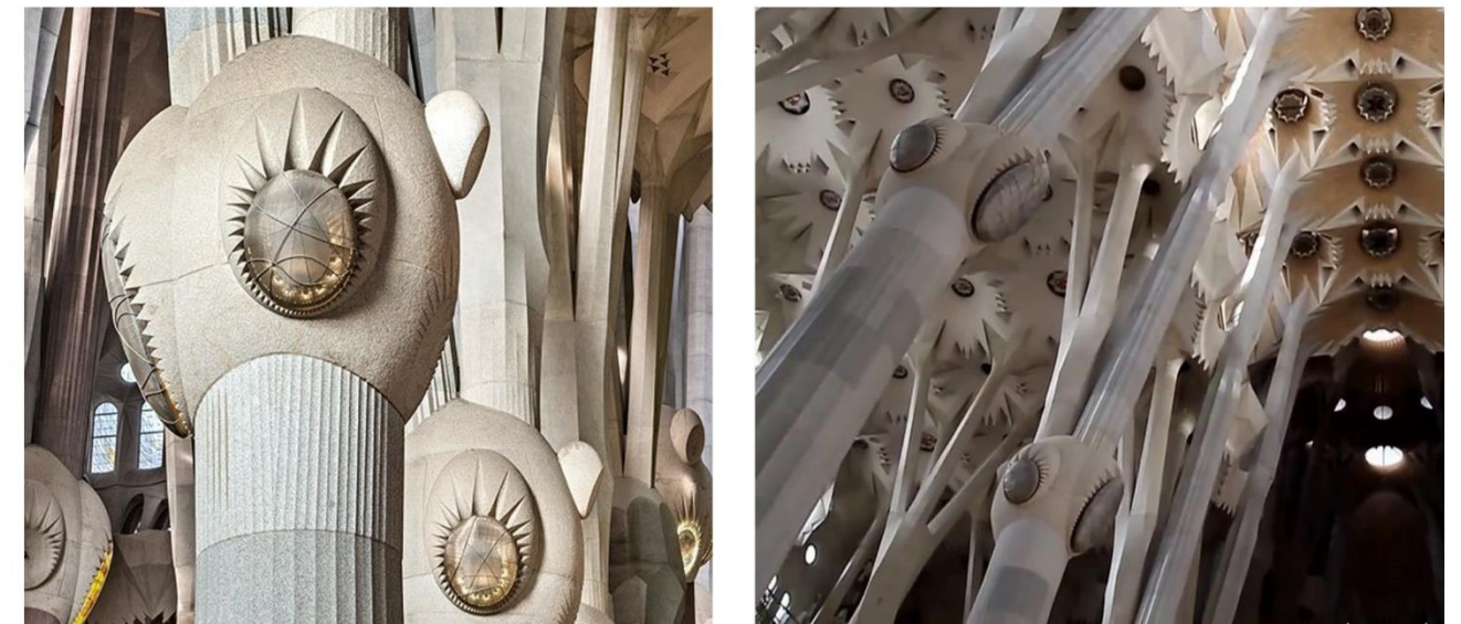
Fig. 73 y 74: Elipsoide en intersección del fuste de las columnas con las ramificaciones superiores. Antoni Gaudí. Sagrada Familia. Barcelona. 1882 - actualidad.
