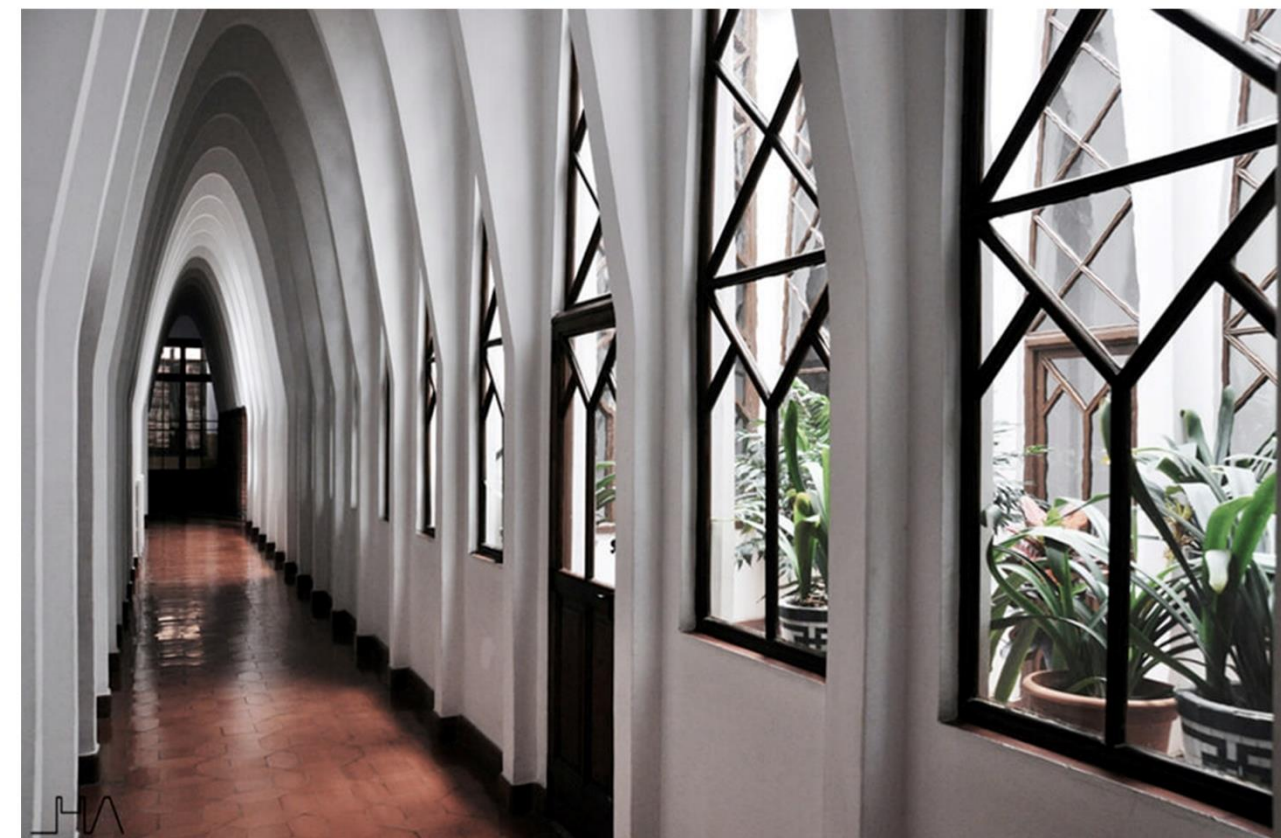
Fig. 43: Antoni Gaudí. Sucesión de arcos parabólicos en primera planta. Colegio de las Teresianas. Barcelona. 1888-1889.
