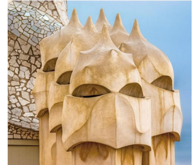
Fig. 69: Coronaciones de chimeneas semejantes a hiperboloides. Casa Milà. Barcelona. 1906-1912.
