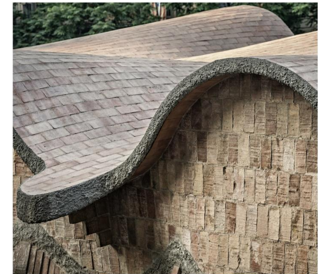
Fig. 79: Cubierta realizada a partir de conoides. Escuelas Sagrada Família. Barcelona. 1909.
