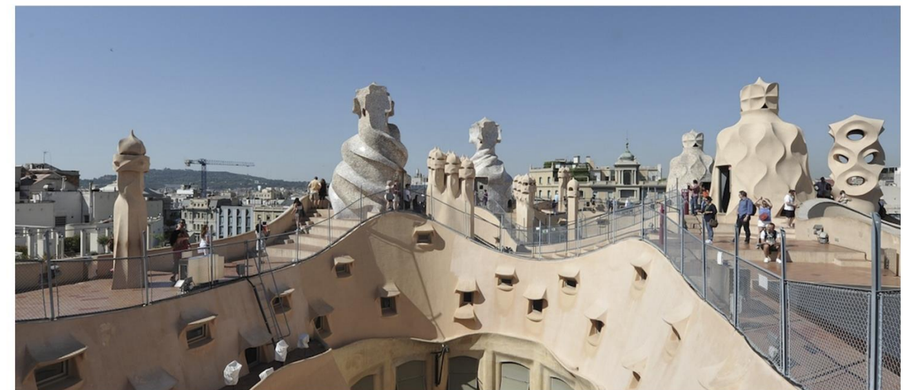
Fig. 39: Antoni Gaudí. Aldarve creado entre la fachada y la cubierta a modo de espacio corredor. Casa Milá. Barcelona. 1906-1912.
