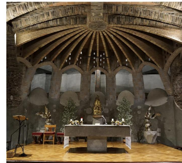
Fig. 70: Hiperboloides creados entre columnas de la nave central. Cripta Güell. Barcelona. 1898.
