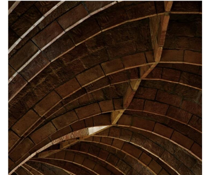
Fig. 38: Antoni Gaudí. Detalle de arcos catenarios en desván. Casa Milá. Barcelona. 1906-1912.
