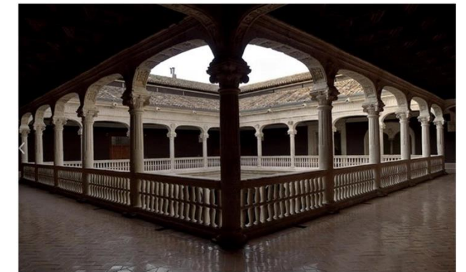
Fig. 42: Arcos carpanel en piso superior del Palacio de los Condes de Miranda. Peñaranda de Duero.
