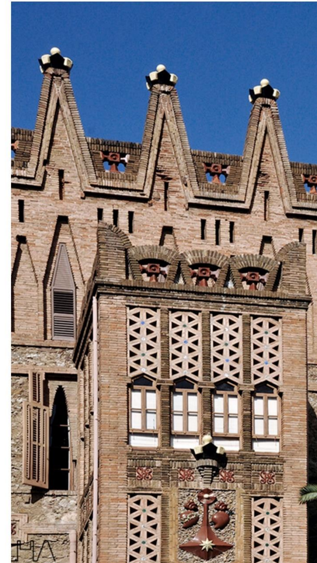
Fig. 48: Antoni Gaudí. Volúmen que sobresale de fachada. Colegio de las Teresianas. Barcelona. 1888-1889.
