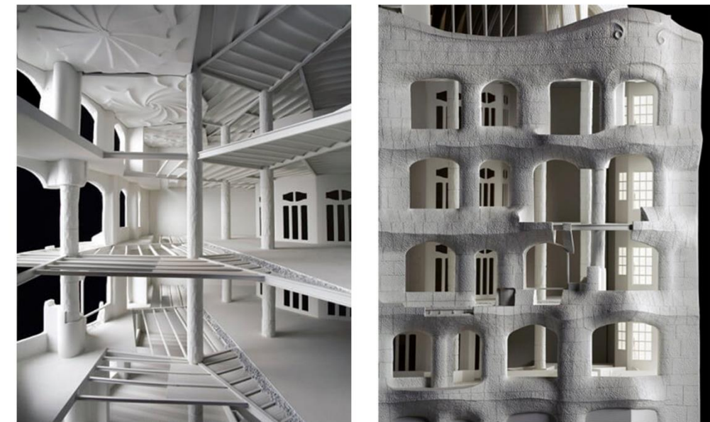
Fig. 35 y 36: Fundació Catalunya La Pedrera. Vistas de maqueta de "La Pedrera". Explicación de fachada libre.
