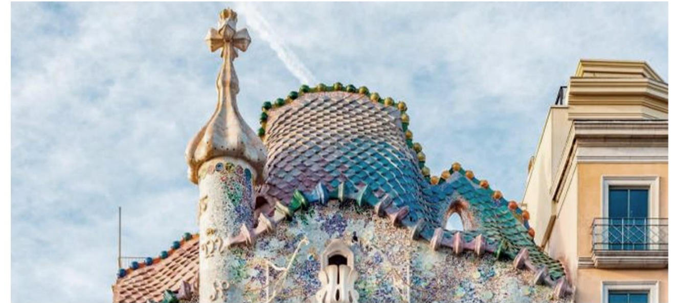
Fig. 31: Antoni Gaudí. Detalle de cubierta aludiendo al dragón. Casa Batlló. Barcelona. 1904-06.
