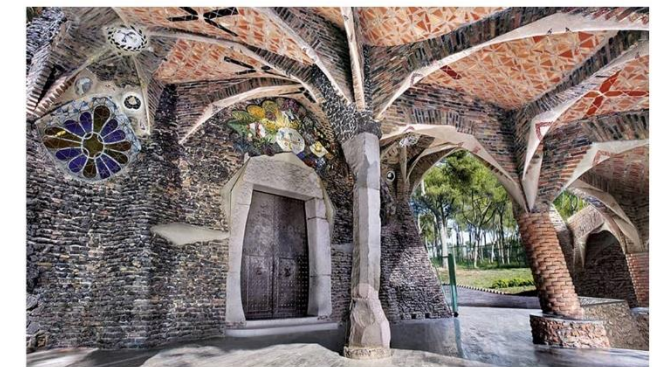
Fig. 54: Antoni Gaudí: Fotografía de la galería exterior, cubierta por paraboloides. Barcelona. 1898.
