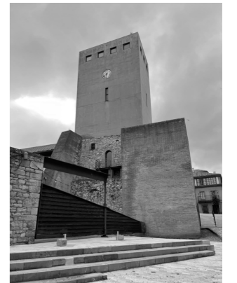
Fig. 16: Fotografía propia. Torre del reloj, 2023.
