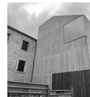
Fig. 43: Fotografía propia. Rehabilitación edificio de la Tabacalera.
