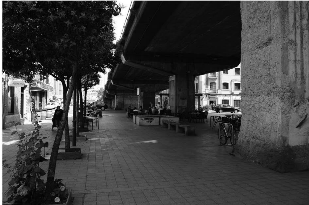
Fig.109. Fotografía de elaboración propia de la salida del túnel hacia el encuentro entre el Paseo de Ladrillo y la calle Puente Colgante.
