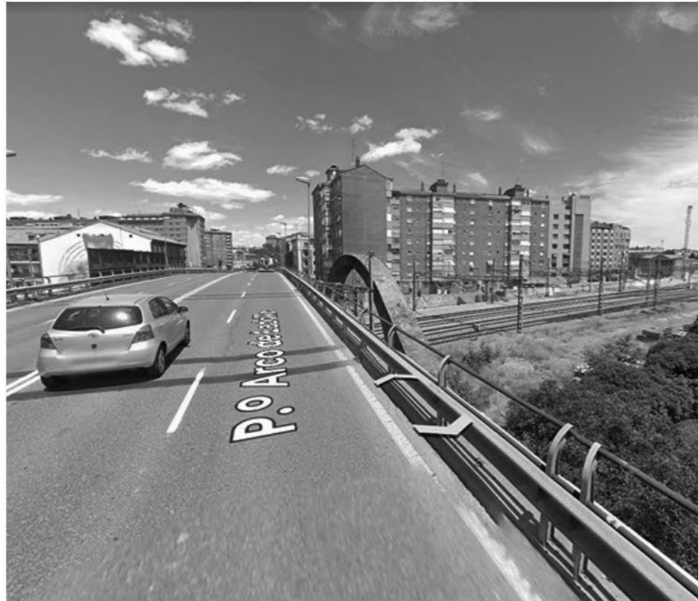
Fig.115. Fotografía del arco y el viaducto de Google Maps.
