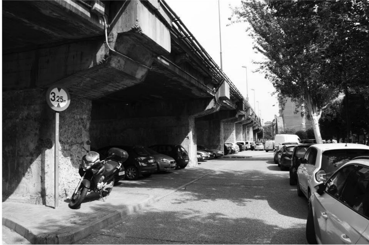
Fig.117. Fotografía de elaboración propia desde el lateral este del viaducto a pie de calle.
