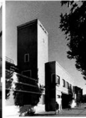
Fig.88. Colomina y Botí, A. (s. f.). Matadero municipal de Valladolid en desuso. Docomomo Ibérico. https://docomomoiberico.com/
