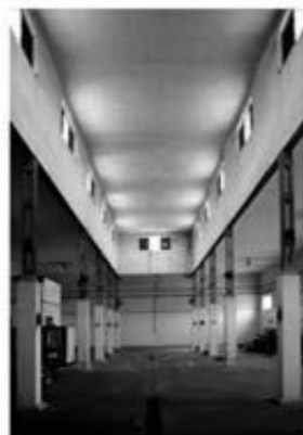
Fig.87. Espacio interior en desuso. (s. f.). Laboratorio de las artes escénicas, LAVA. https://grijalbaarquitectos.com/portfolio/laboratorio-de-las-arte-escenicas-lava/
