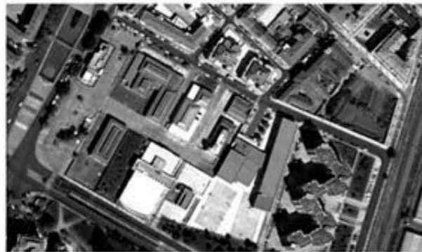
Fig.89. Fotografía aérea. (2006) Google earth Pro.
