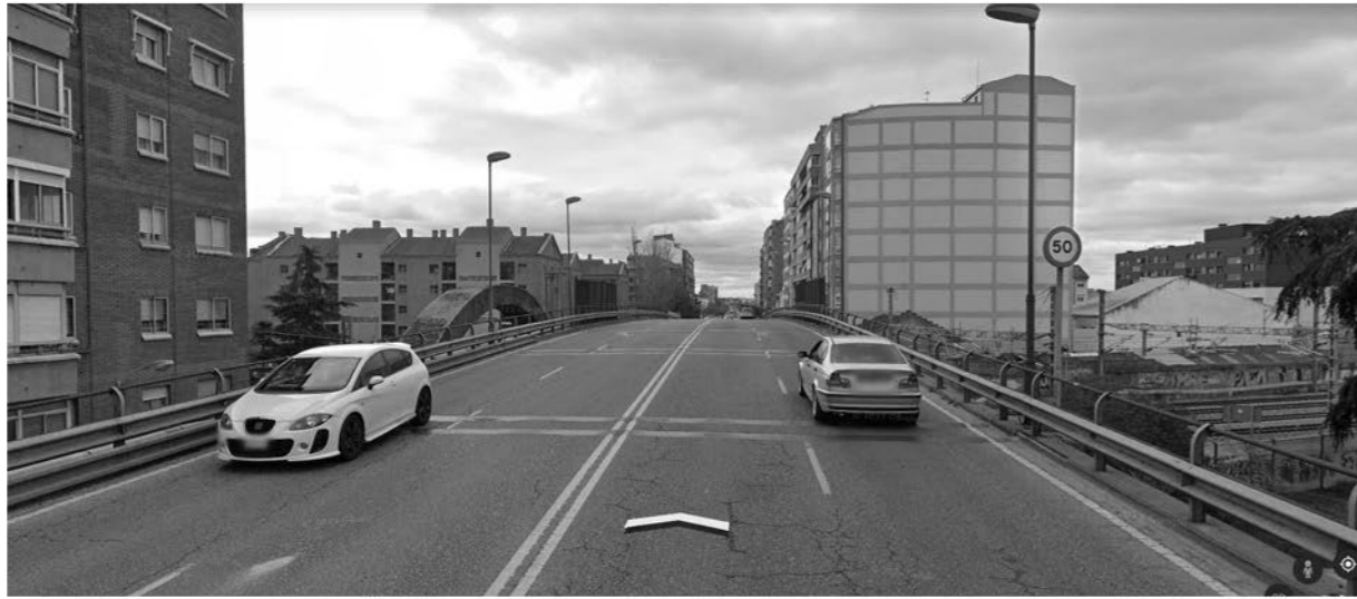
Fig. 113. Fotografía tomada de Google Maps desde el propio viaducto. Se ve la relación entre las vías, el arco, los vehículos y las viviendas de los vecinos.
