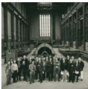
Fig. 44. Imagen del equipo de Herzog & de Meuron previo al inicio de la obra. Herzog & de Meuron : 5, 2002-2004 / the complete works. Gerhard Mack/ Mack, Gerhard
