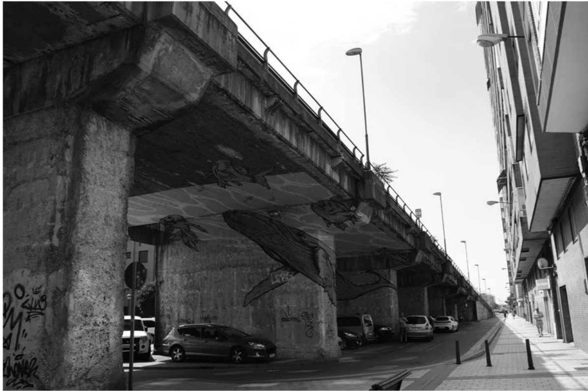
Fig.107 . Fotografía de elaboración propia del viaducto desde la salida del túnel.
