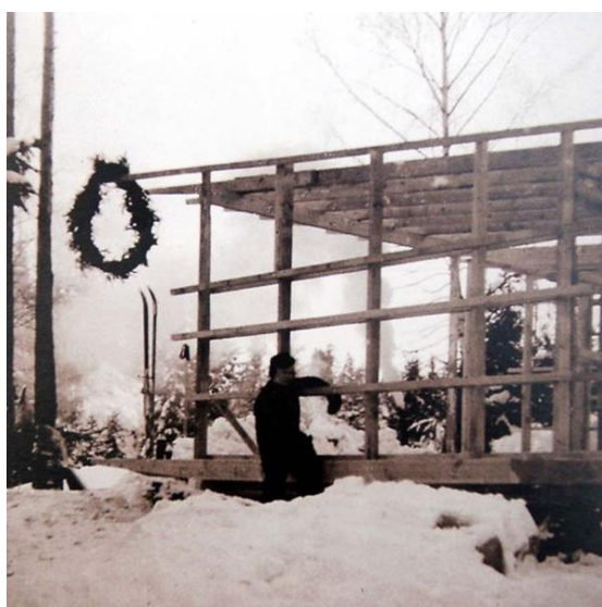
Ilustración 2: Estructura de madera de The Box en estado de construcción. Fuente: https://shorturl.at/xEPY0
