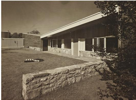
[21] Casa Geller I (1944) Diseñada por M.Breuer, donde la materialización es una combinación entre la piedra de Connecticut y la madera de ciprés. Materiales muy usados en sus proyectos.
