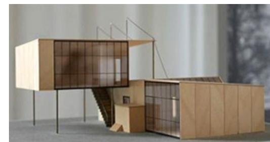
[14] CASAS BAMBOS (1927) es un proyecto de Breuer, donde diseña 7 casas-estudio para jóvenes maestros. Su esqueleto es de acero y sus cerramientos de paneles prefabricados. Aparecen elementos recurrentes como la adición de dos volúmenes, disposición sobre pilares de uno de los cuerpos, leve pendiente de las cubiertas, estricta separación entre zona de trabajo y vivienda.
