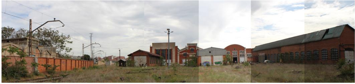
Nave de montaje 1 y 2. Fotografía propia.
