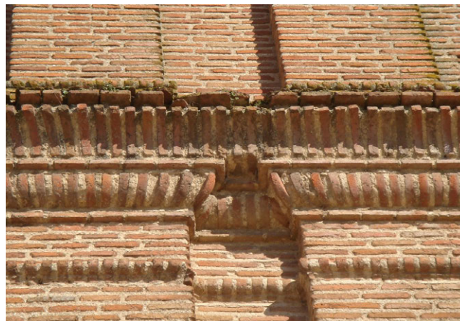
Figura 1. A la izquierda remate de una tapia con hiladas inclinadas, a la derecha cornisa de ladrillos vegetación y donde se han desprendido varias piezas.
