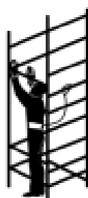
USAR CINTURÓN EN MONTAJE Y DESMONTAJE
