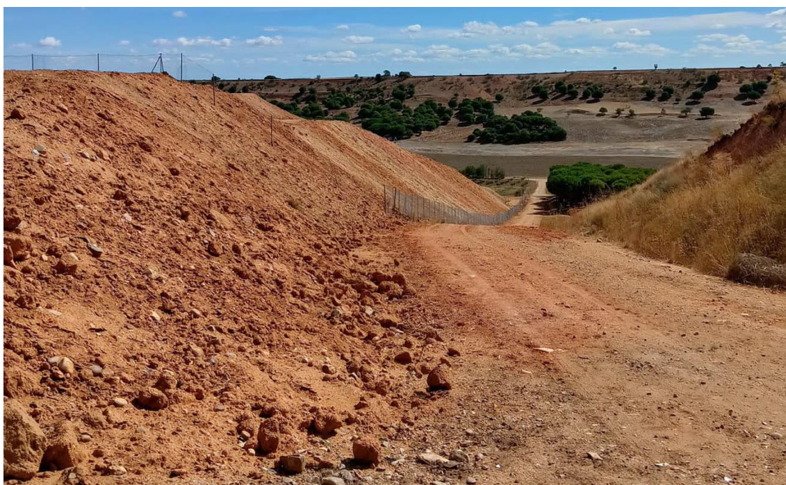
Figura 11. Fotografía del talud oeste, con el camino rural colidante (26/09/2022). Fuente: Elaboración propia.
