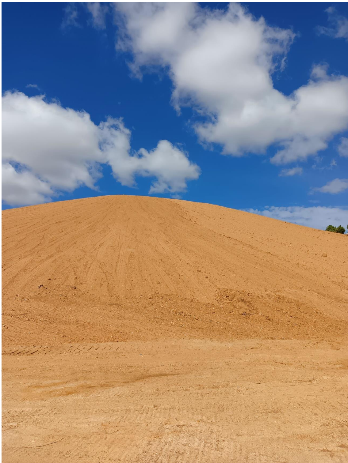
Figura 12. Ladera sur vista desde la plataforma inferior. Fuente: Elaboración propia, 26/09/2022.
