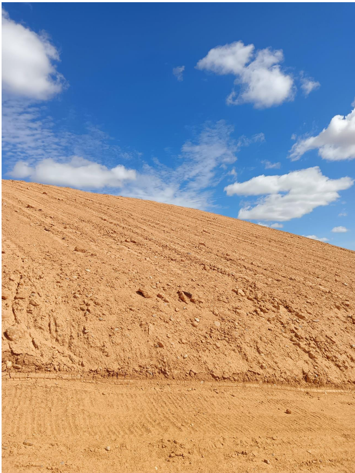
Figura 9. Detalle del talud oeste. Fuente: Elaboración propia, 26/09/2022.
