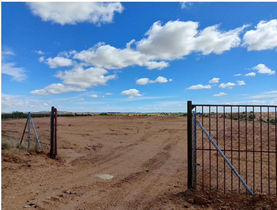
Figura 3. Detalle de la puerta de entrada del cerramiento perimetral a la plataforma superior. Fuente: Elaboración propia, 26/09/2022.
