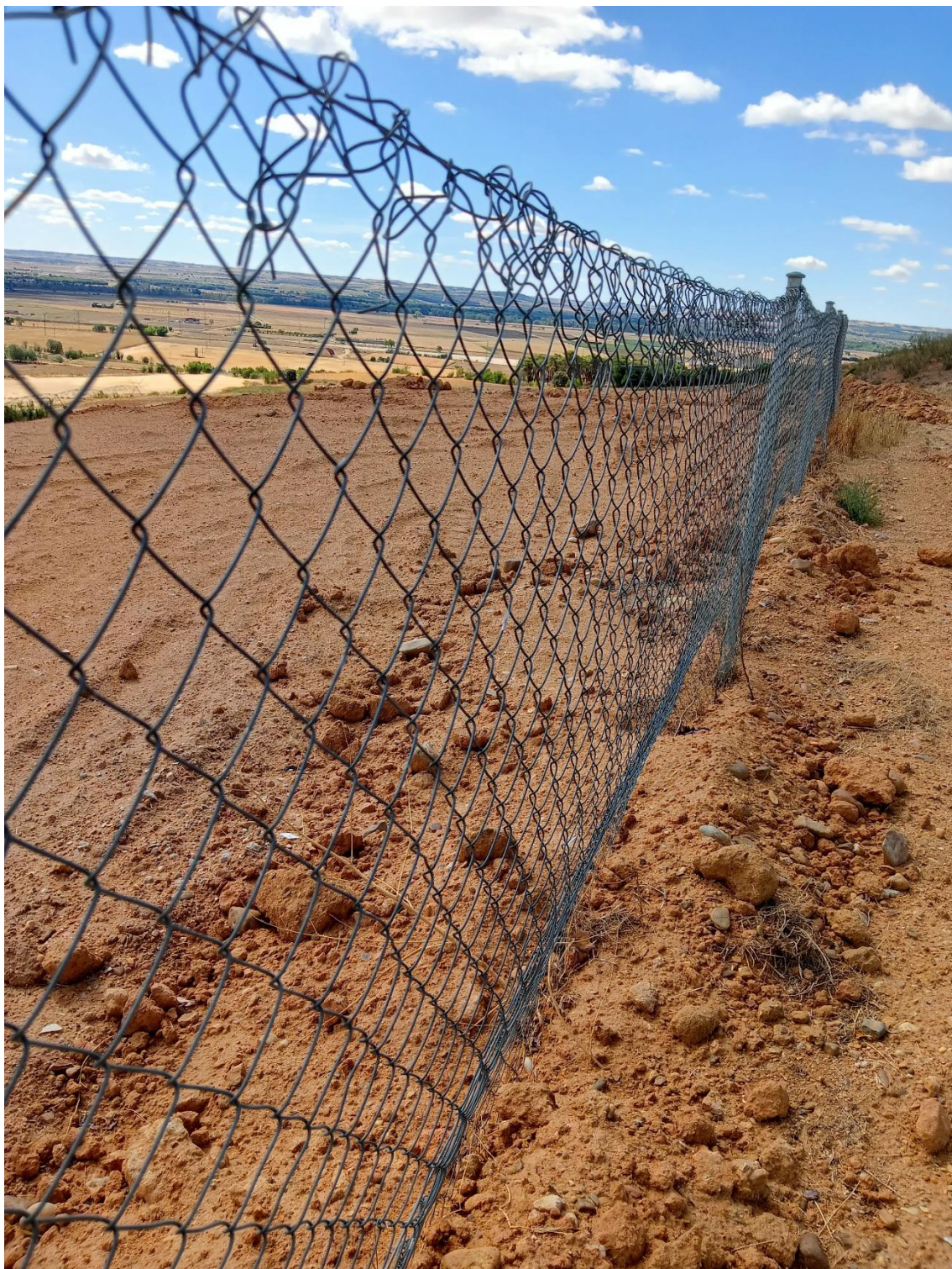
Figura 4. Detalle del cerramiento perimetral. Fuente: Elaboración propia, 26/09/2022.
