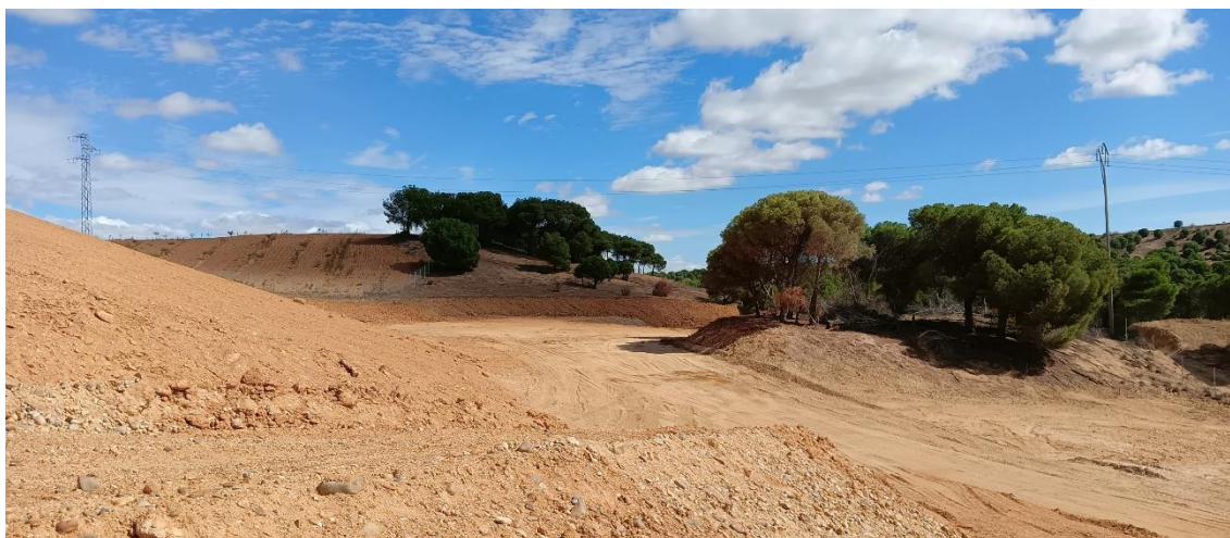
Figura 4. Fotografía de los recintos 5 (derecha) y 6 (centro izquierda), con ejemplares de Pinus pinea. En el recinto 3 se ha realizado la plataforma inferior, en la que por ahora no se ha instalado vegetación. Fuente: Elaboración propia.
