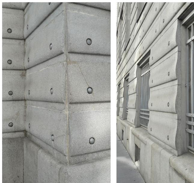
Figura 8. Izquierda, esquina basamento en Postsparkasse. Derecha, placas de espesor variable y aspecto moldeable en Postsparkasse (R. Gallego-Blázquez).
