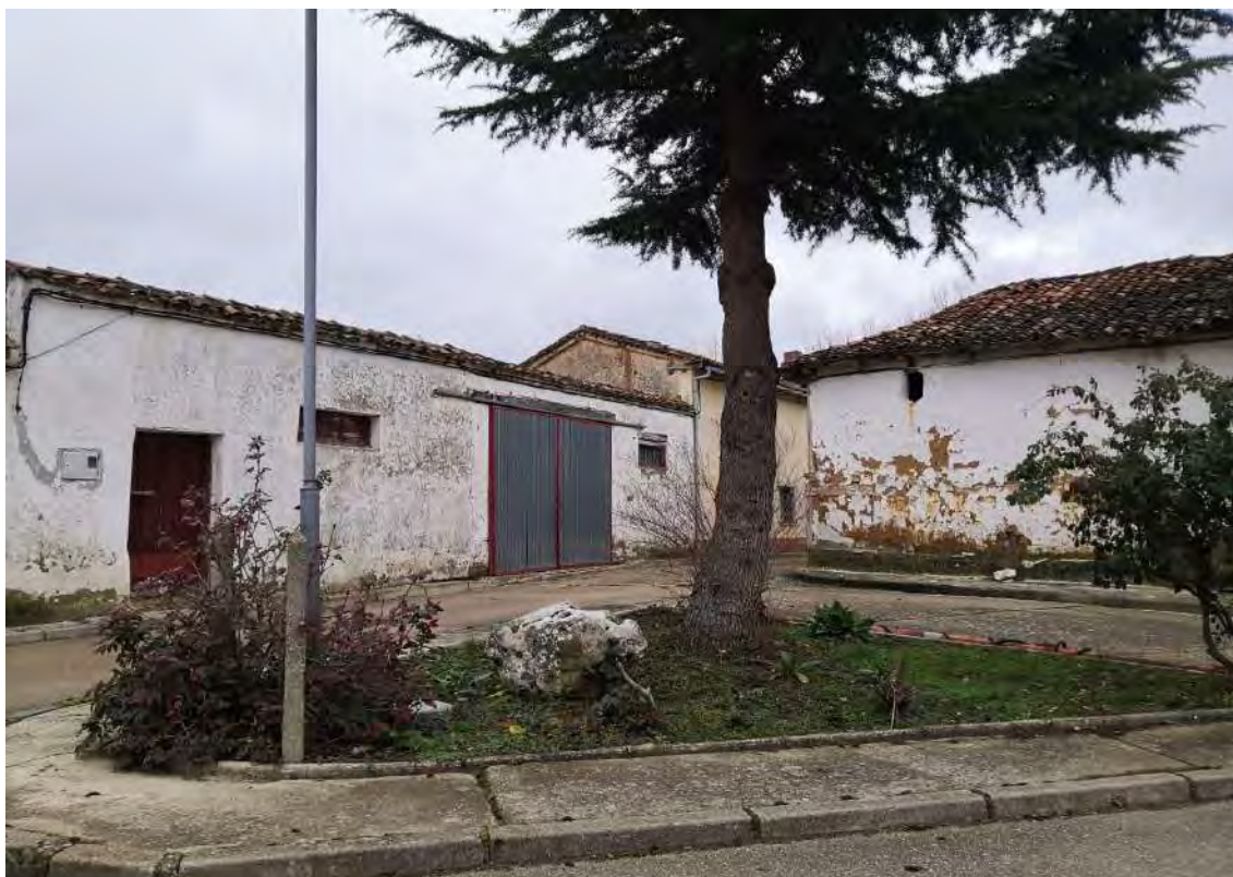
Figura 23. Rotonda sin fuente de Arenillas de San Pelayo (Fuente: propia).
