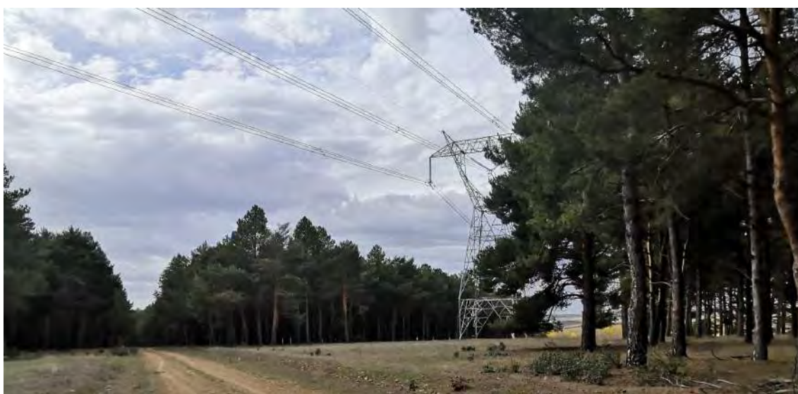
Figura 43. Tendido eléctrico que cruza la senda (Fuente: propia).
