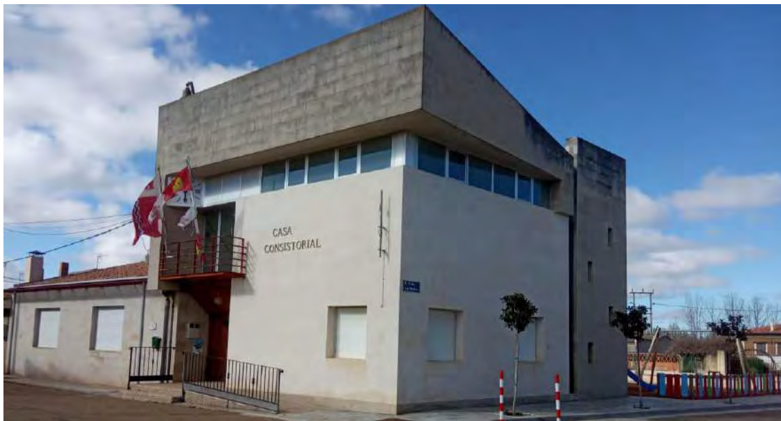
Figura 4. Ayuntamiento de Villaeles de Valdavia (Fuente: propia).
