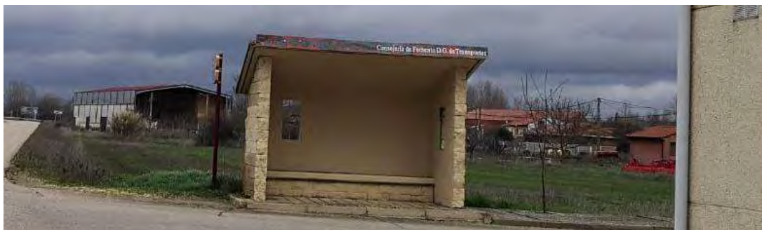
Figura 16. Parada de autobús de Arenillas de San Pelayo (Fuente: propia).
