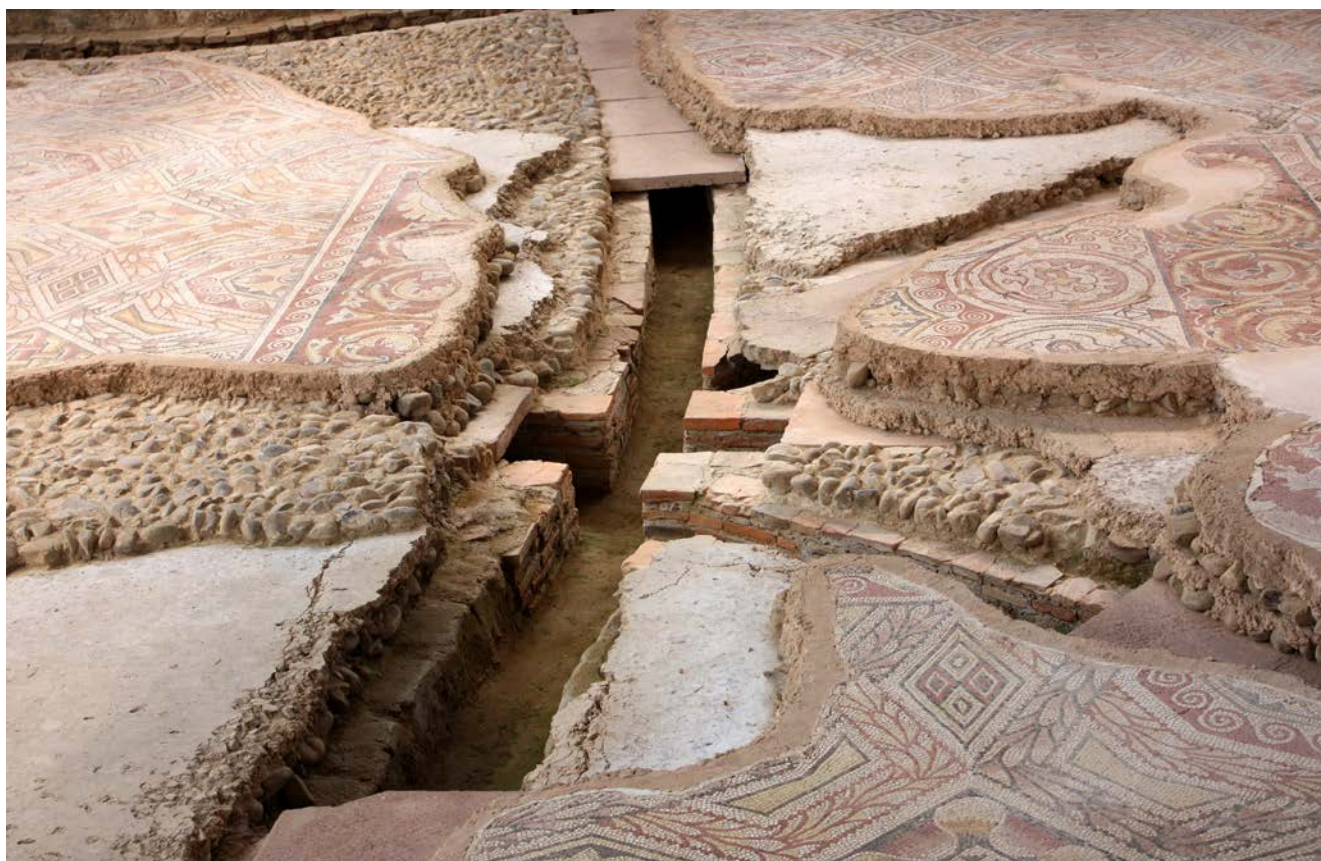
Figura 3. Habitación B-12, destrucción producida al recuperar los ladrillos (C. Gamarra).
