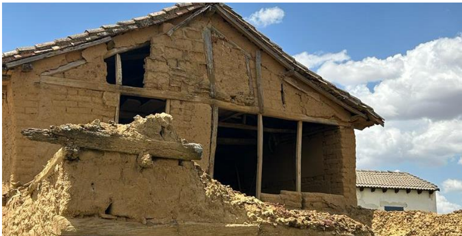
Figura 6 Casa en ruinas con entramado de madera en San Pedro de las Dueñas
