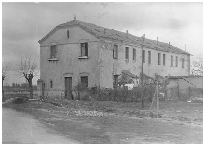
Imagen 9 Una de las pocas casas construidas dentro del proyecto de Ciudad Jardín.
