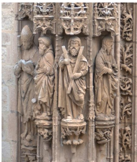
Fig. 41: Nivel inferior del contrafuerte izquierdo ( San Ambrosio de Milán, San Bartolomé, San Andrés y San Pablo ). (Foto del autor, 2023).
