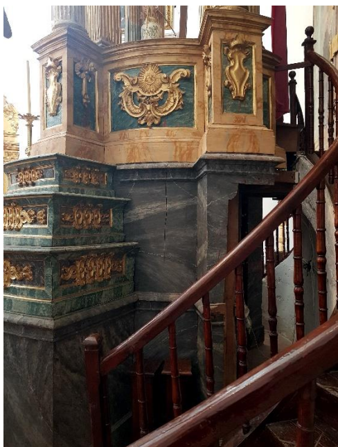
Fig. 3. Tabernáculo de la iglesia de San Ildefonso de Toledo. Detalle de uno de los accesos laterales
