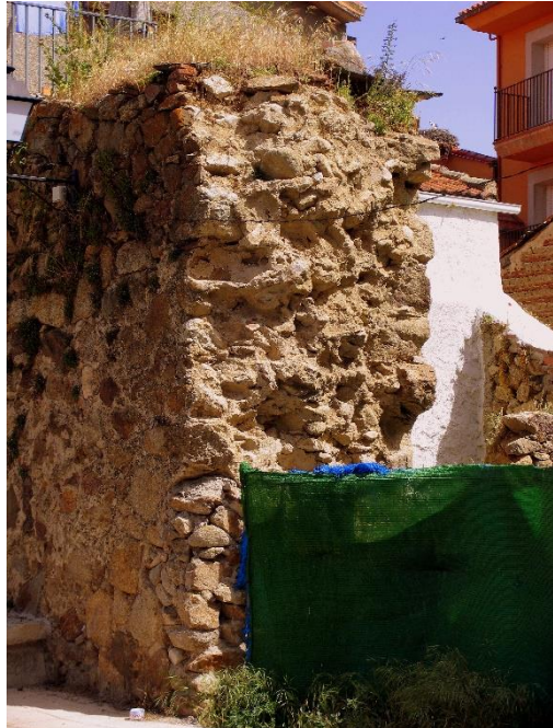
Fig. 1. Materiales constructivos de la muralla de Piedrahíta (Ávila)
