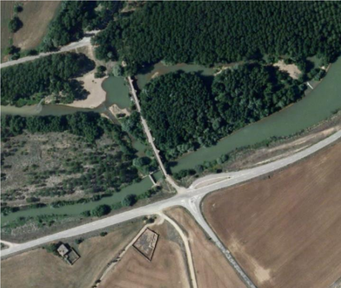
Figura 61. Ortofoto del PNOA 2017 puente de Astudillo. Fuente: PNOA.
