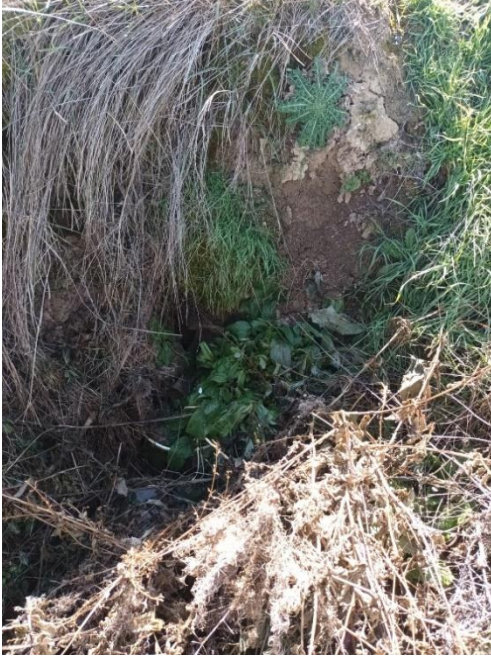
Fotografía de la fuente de Erilla antes de ser reparada. Fotografía propia.
