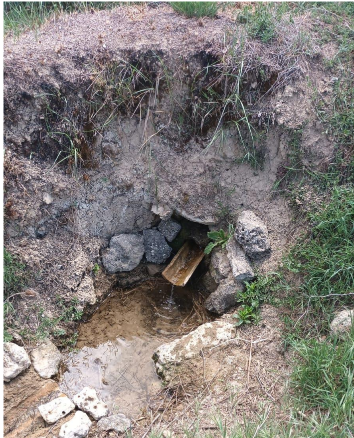
Fotografía de la fuente de Erilla después de ser reparada. Fotografía propia.
