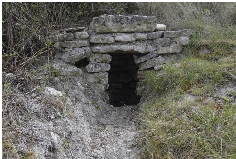
Fotografía de la fuente de Caravante después de ser reparada. Fotografía cedida por Sergio Ordax Teso.
