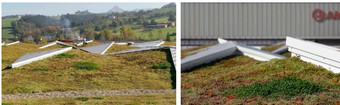
Figura 13. Cubierta verde en una nave de mecanizado industrial de Ampo (6.800 m 2 instalados), Idiazabal, Guipúzcoa.
