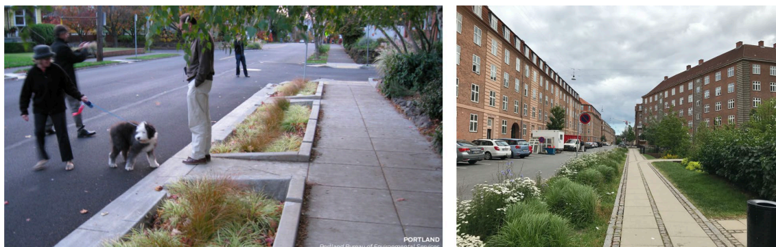
Figura 4. A la izquierda: Franja filtrante en Portland, Oregón, Estados Unidos. ( https://nacto.org/publication/urban-street-stormwater-guide/stormwater-elements/ ). A la derecha: Cuneta verde en el barrio de Saint Kjeld, Copenhague, Dinamarca. (R. del Caz).
