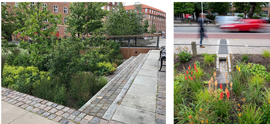
Figura 7. Jardines de lluvia. Izquierda: Copenhague. (R. del Caz). Derecha: Wood Green, en Londres. ( https://www.elblogdelatabla.com/2020/01/jardin-lluvia-urbano-drenaje-sostenible-valor-social-medioambiental.html ).
