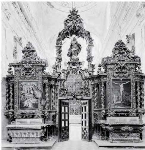
Figura 15 - Muro de entrecoros en la iglesia de Santa María de El Paular h. 1905. (Fuente: Buces Aguado, 1994).
