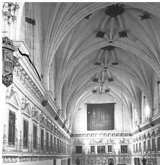
Figura 26 - Cornisa y yeserías añadidas en el siglo XVII.
