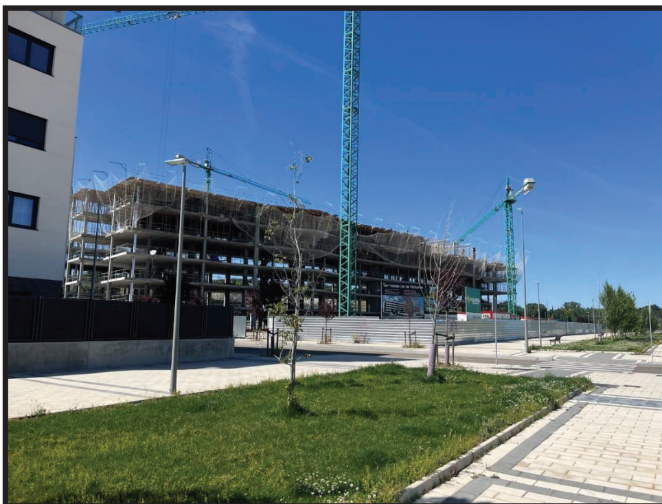
Figura 33 Proceso de construcción de las viviendas de la Parcela 11 “Las terrazas de la Victoria”
