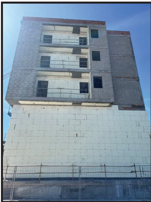
Figura 29 Proceso de construcción de las viviendas “Residencial el Brezo”
