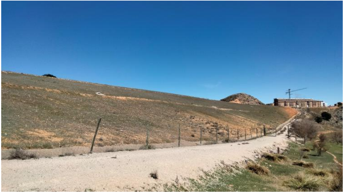
FIGURA 20. Vertedero de la Rumba.
