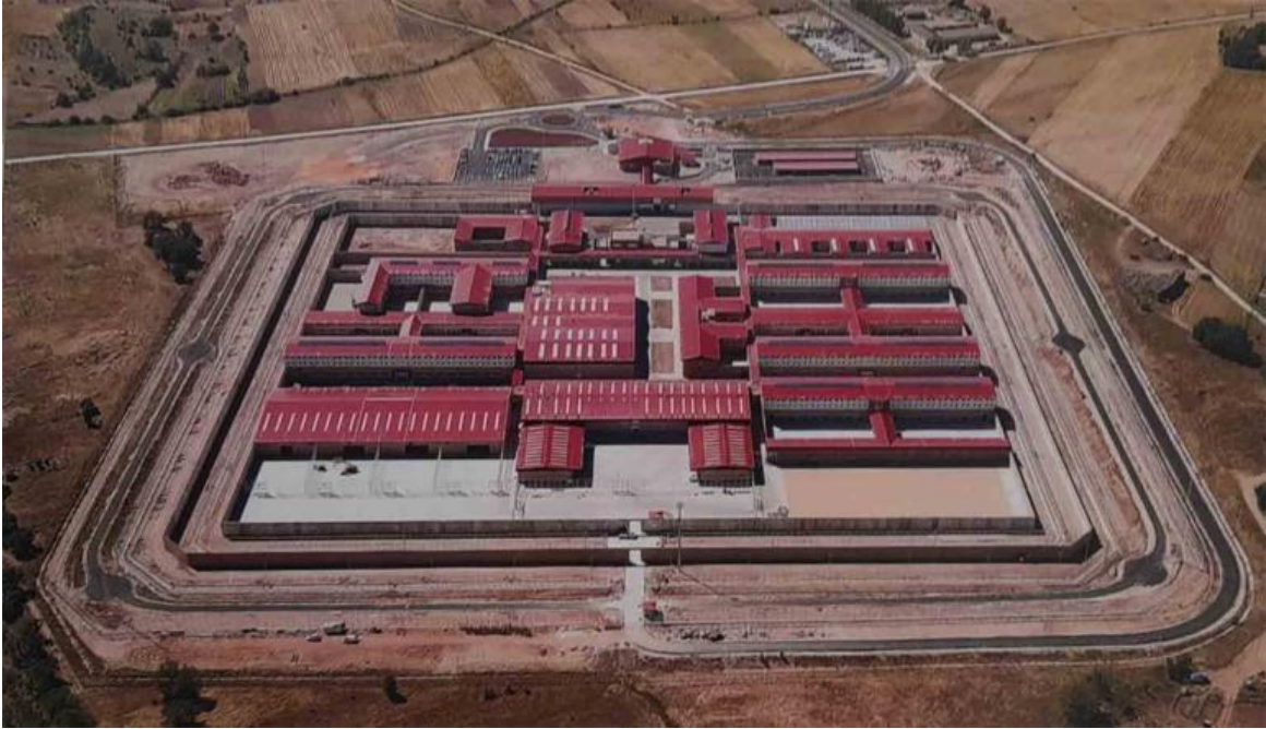
Figura 37. Centro penitenciario de Soria
