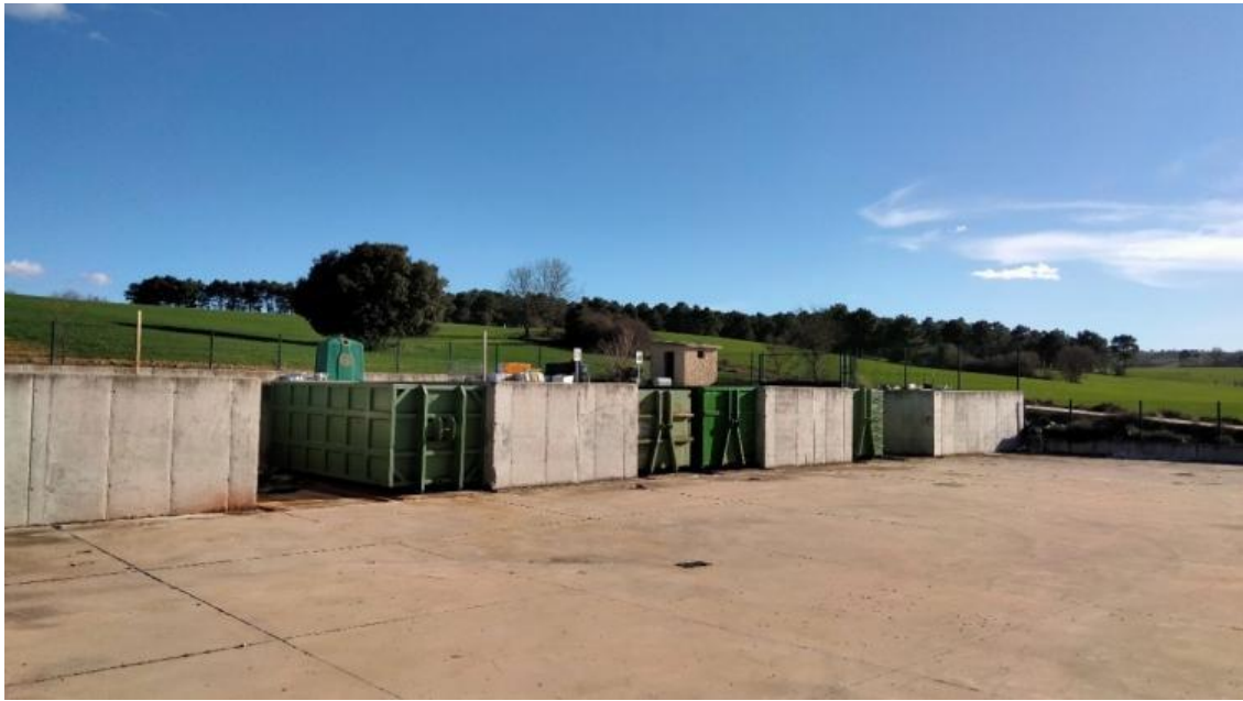
Figura 26: Punto Limpio de Garray
