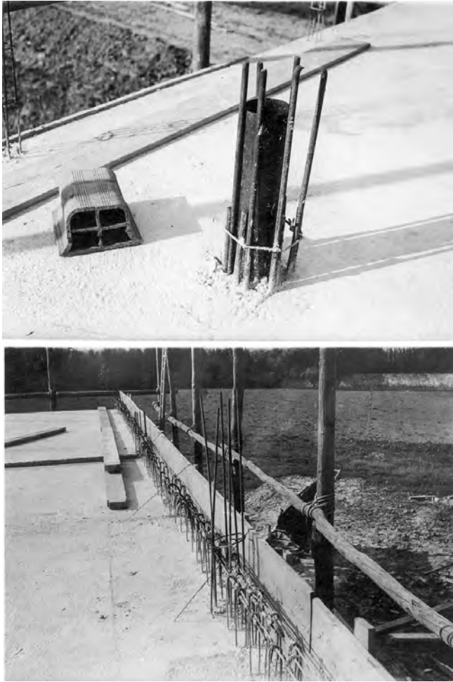
Figura 5. Fotografías del forjado de techo de planta baja de la Villa Savoye , del 14 de mayo de 1929, posiblemente de Norman Rice (FLC-L2-17-202 y 204). Fuente: Fondation Le Corbusier.
