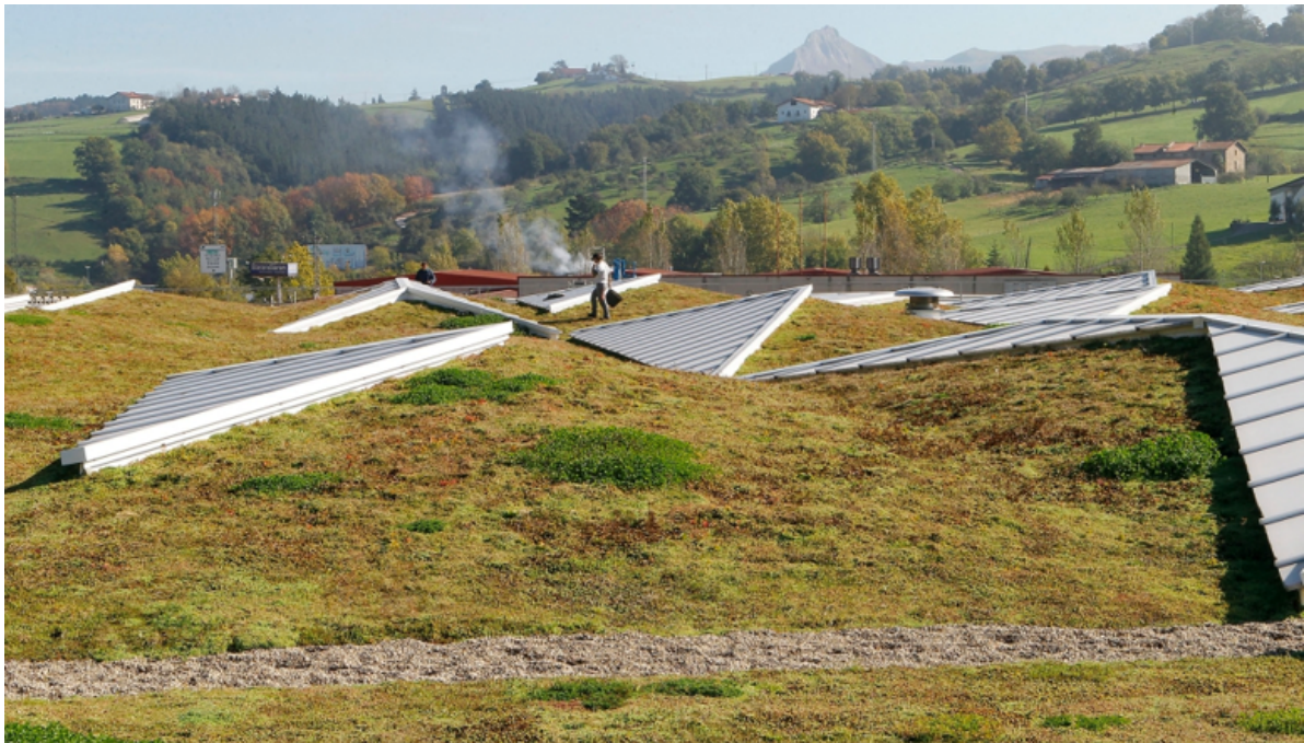
Fig. 28. Cubierta verde en una nave de mecanizado industrial de Ampo, Idiazabal, Guipúzcoa.
