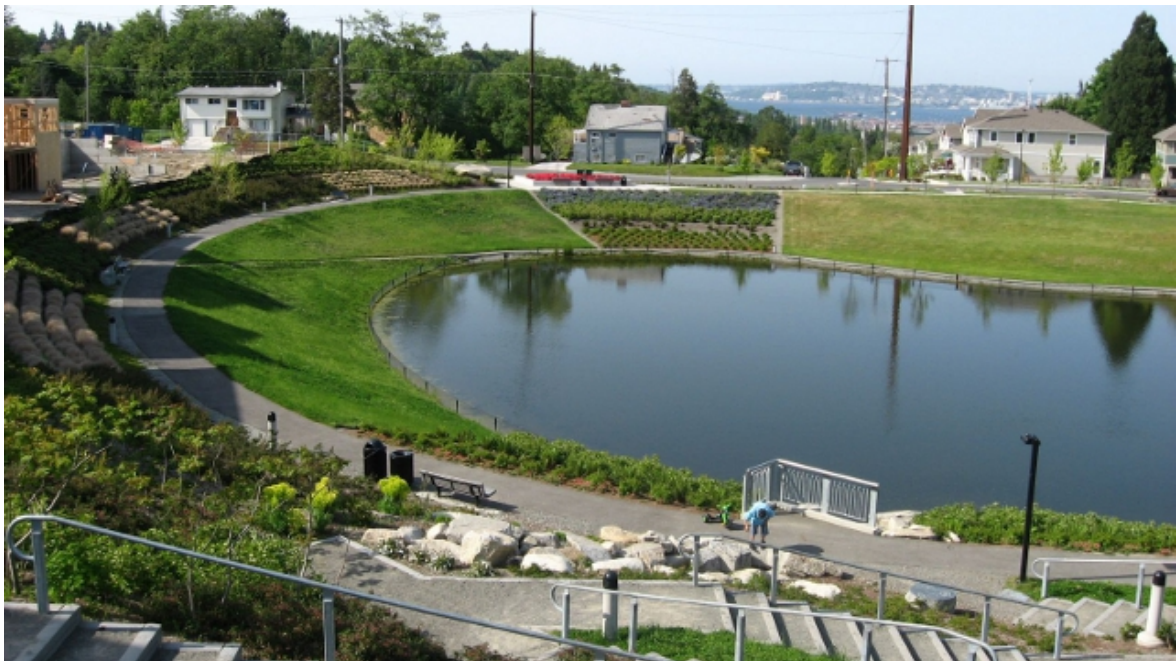
Fig. 21. Estanque de retención. Fuente: Sudsostenible, http://sudsostenible.com/tipologia-de-las-tecnicas/medidas-estructurales/estanques-de-retencion/
