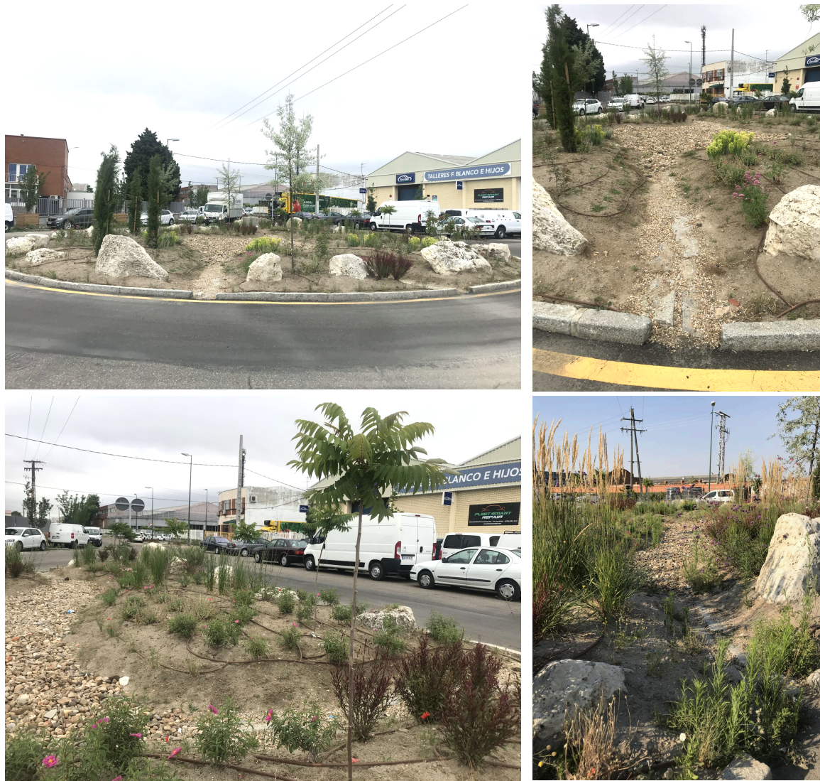
Fig. 17, 18, 19 y 20. Jardín de lluvia construido en la rotonda de la calle Pilar Miró del polígono de Argales. Fuente: M. Rosario del Caz Enjuto (UVa).
