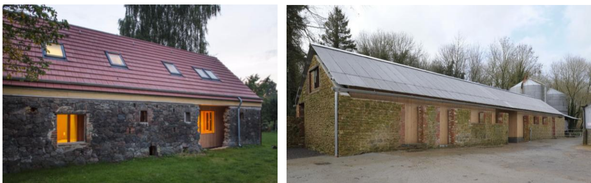
Figuras 4 y 5: Rehabilitación de una granja en Schöneiche (proyecto y fotografía: Alexander Palowski) y Archivo de arquitectura (proyecto: Hugh Strange; fotografía: David Grandorge).
