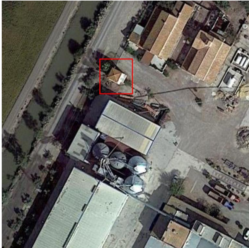
Ilustración 107. Caseta donde se ubicarán inversor y protecciones eléctricas.
