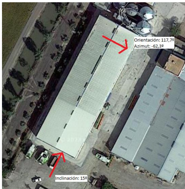
Ilustración 31. Vista aérea del emplazamiento.
