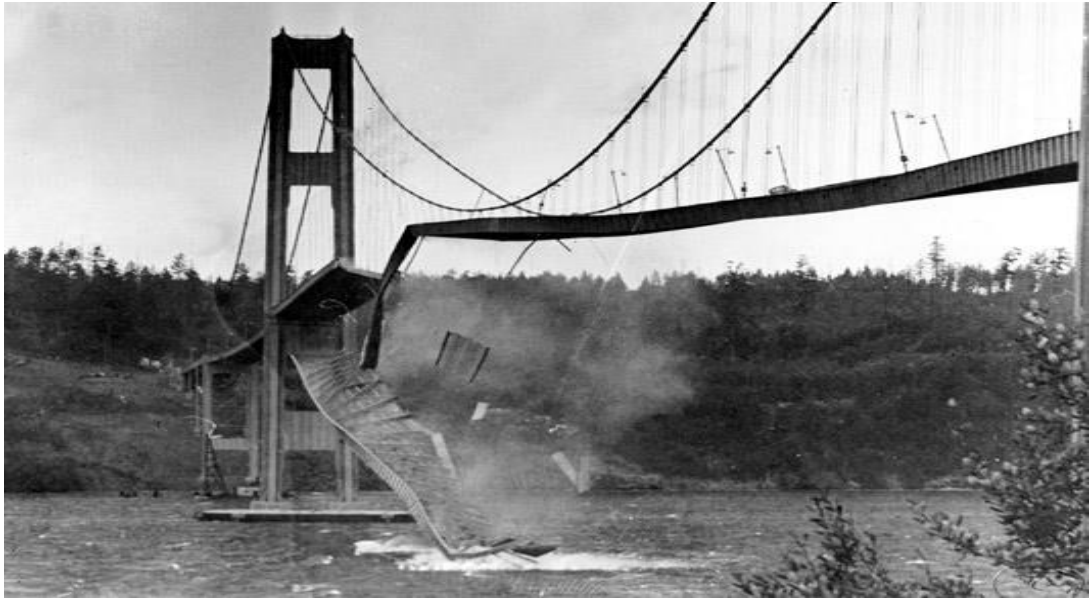
Figura 1. Colapso del Puente de Tacoma. [1]
