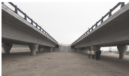
Fig. 26. Vista interior de una de las áreas de excavación dispuesta para instalar las Aulas Arqueológicas de Lancia, 2018. Fotografía de LAB/PAP.
