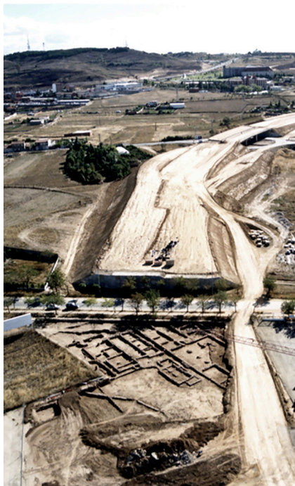
Fig. 1. Vista aérea de las excavaciones previas a la construcción de la Ronda Sur LE-30 de la ciudad de León. Intersección con la Avenida de San Froilán. Se puede observar la segunda fase de excavación, realizada en 2001, la primera fase de octubre 2000 se encuentra ya cubierta por el talud de la Ronda. Fotografía de J.C. Álvarez Ordás. En: MORILLO CERDÁN, A. et al. El vicus militar de Ad Legionem (Puente Castro, León). Las intervenciones arqueológicas de los años 2000-2001. En: SPAL. Revista de Prehistoria y Arqueología . 2018, pp.145-183.
