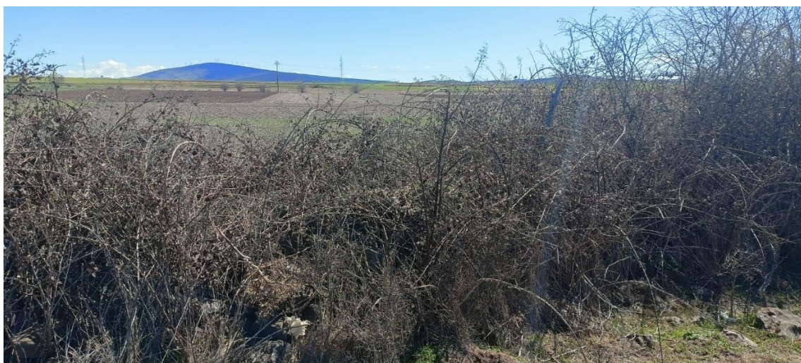
Figura 8. Estado actual del cerramiento sureste de la parcela.
