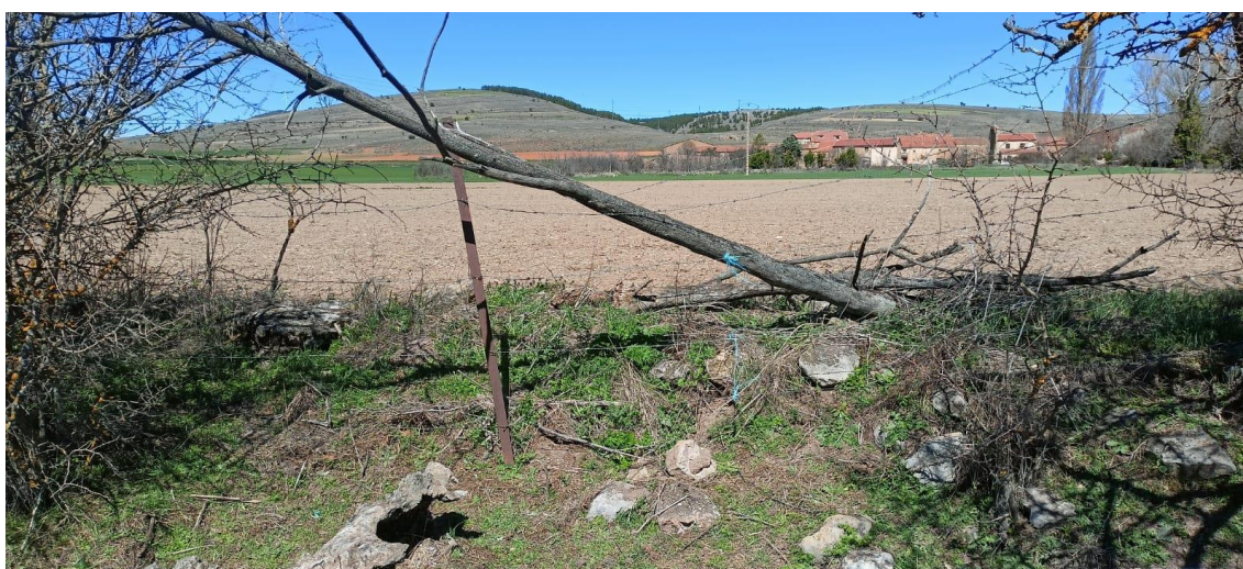
Figura 8. Vallado de la explotación afectado en uno de los tramos del perímetro. Fuente: elaboración propia.
