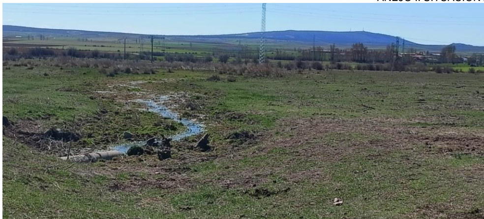
Figura 5. Tubería de desagüe de la parcela. Fuente: elaboración propia.
