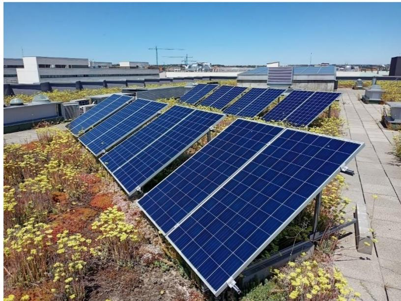
Figura 54. Paneles conectados al inversor bidireccional (planta piloto, Edificio LUCIA, Univ. de Valladolid). Fuente: Elaboración propia.
