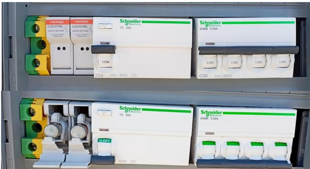
Figura 34. Protecciones del inversor INGETEAM conectadas (arriba) y desconectadas (abajo). De izquierda a derecha se muestran los fusibles, interruptor diferencial e interruptores automáticos. Fuente: Elaboración propia.
